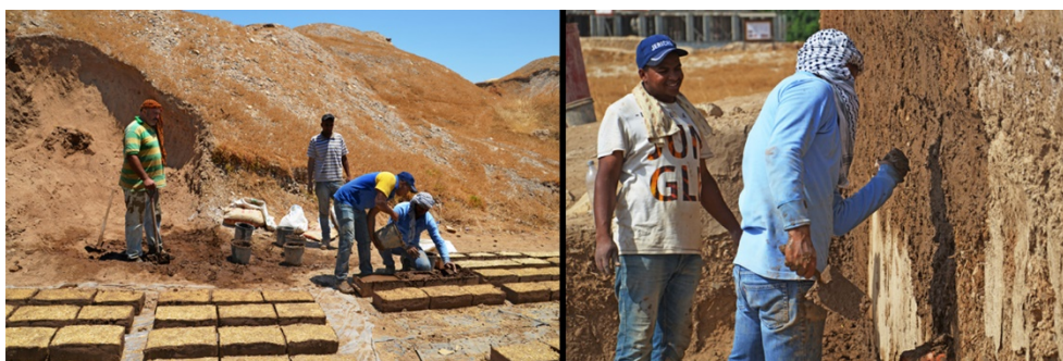
Fig. 2 - Alcuni momenti delle attività di restauro sul sito di Tell es-Sultan: la realizzazione dei mattoni crudi secondo le tecniche tradizionali (sinistra) e la messa in opera dei mattoni (destra).
