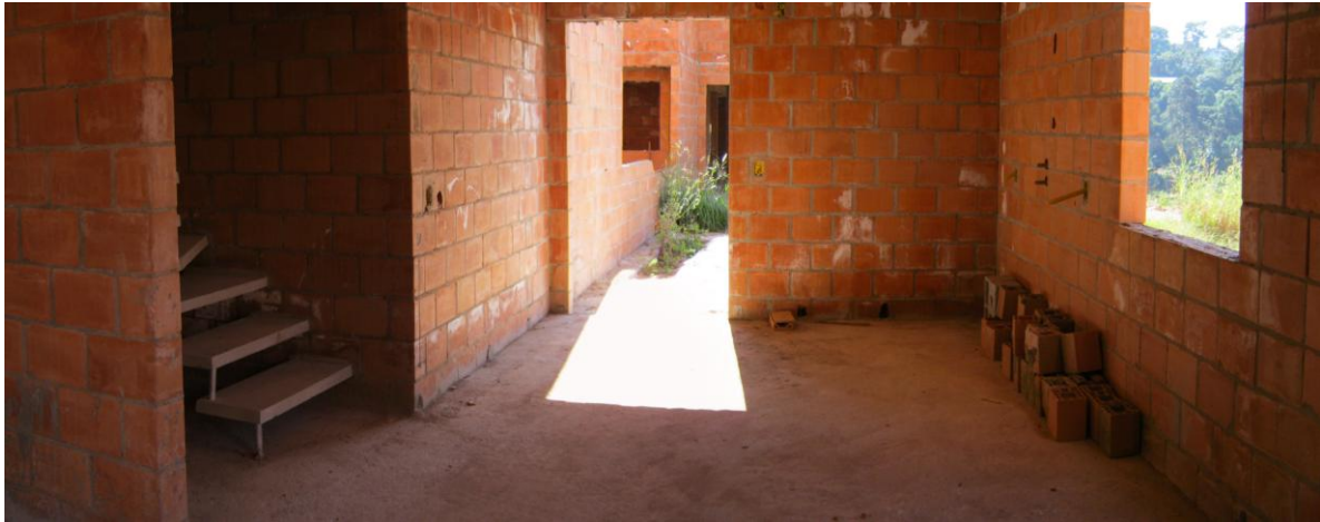
Construção de uma casa junto à outra casa. Fonte: Usina.
