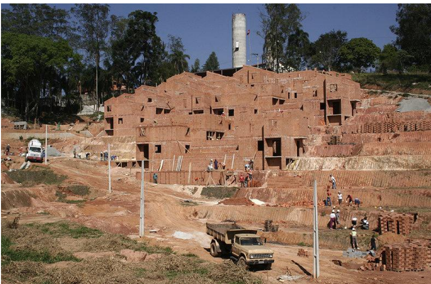
Figura 31: Trabalho na obra da Comuna.
