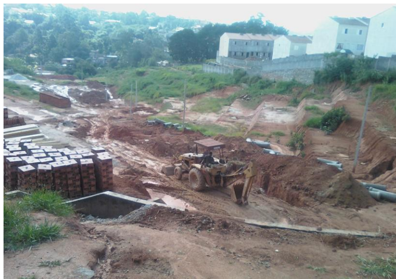
Figura 30: Obra no terreno da Comuna.
