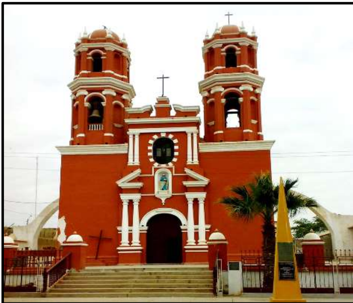
Figura 70. Fachada de la Iglesia de San Pedro de Mórrope
