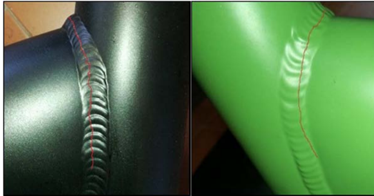
Figura 3.1.3. Esempi di rotture della saldatura nella zona superiore
