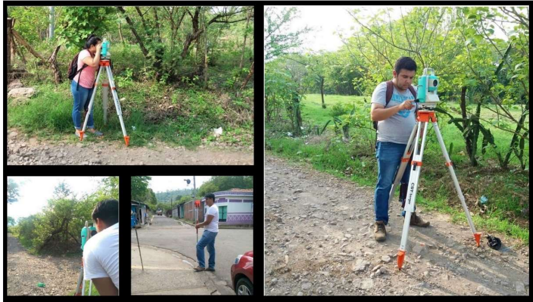
Imagen 2. Levantamiento topográfico de los alrededores del área urbana del municipio de Chilanga.
