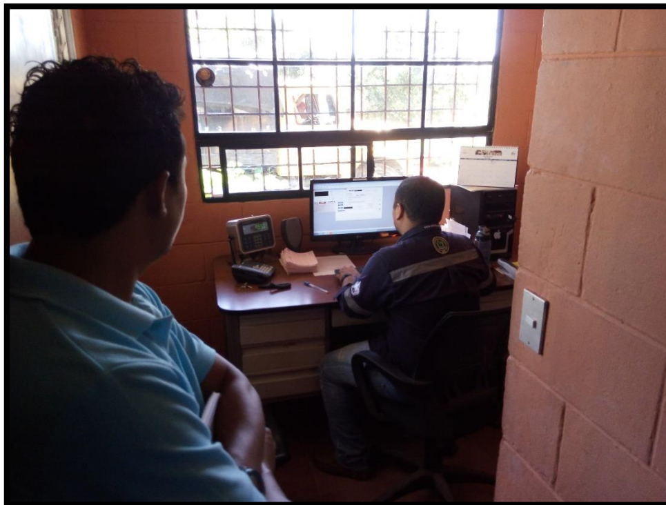
Figura 32. Estación de Control Relleno Sanitario
