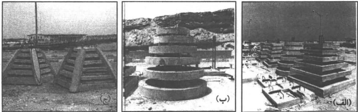
شکل ۲: سازه‌های طراحی و ساخته شده برای ایجاد زیستگاه‌های مصنوعی دریایی شاه میگو. (الف) سازه هرم ناقص مطابق چهارگوش، (ب) سازه مخروط ناقص مطابق یا گرد، (ج) هرم چهارگوش مطابق بسته جدول ۱: مشخصات فنی سازه‌های طراحی و ساخته شده برای ایجاد زیستگاه‌های مصنوعی دریایی در رمین
