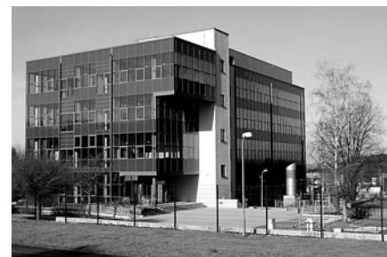
Das neue Laborgebäude der Universität Bielefeld. Auch bei Campus-Management-Systemen müssen Architekturentscheidungen Flexibilität ermöglichen und Veränderungsanforderungen berücksichtigen.
