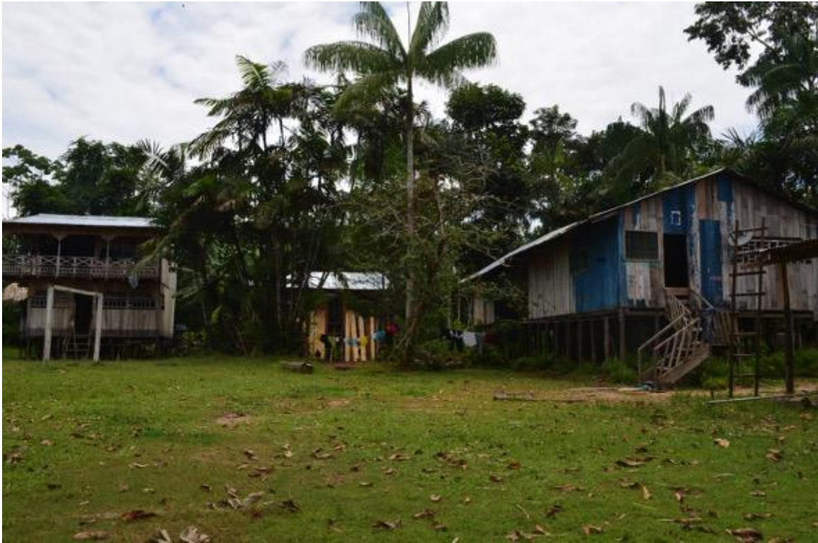
Figura 11. Comunidad Santa Clara de Tarapoto. Sus viviendas son altas, debido a que esta es área de inundación, cada una de las casas cuenta con un nombre del clan de la familia que allí habita.
