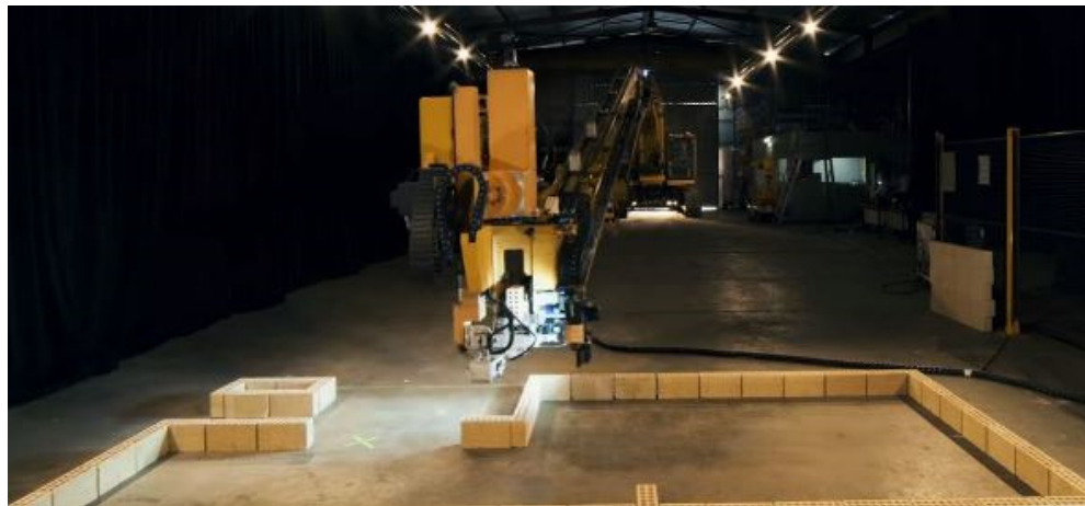
Figura 11. Robot Adrian, constructor de paredes de ladrillo.
