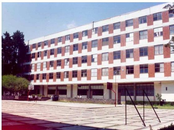
Construcciones de la Facultad de Química 1987 en Unidad "El Cerrillo": Aula, Planta Piloto de Alimentos y Planta Piloto de Ingeniería Química, y en Unidad Toluca: Vista desde oriente del edificio de 5 plantas con estructura de columnas encamisadas y recimentado su asentamiento.
