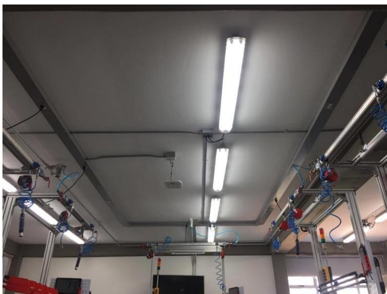
Ilustración 26. Redes de aire, iluminación, eléctrica y datos.
