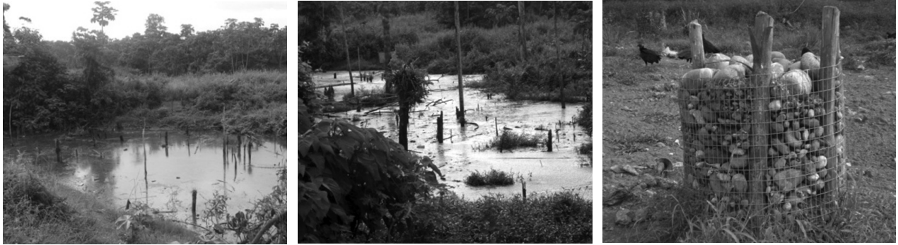
Imágenes N° 17,18 y 19: Fosa de Lixiviados, chimeneas de biogás.
