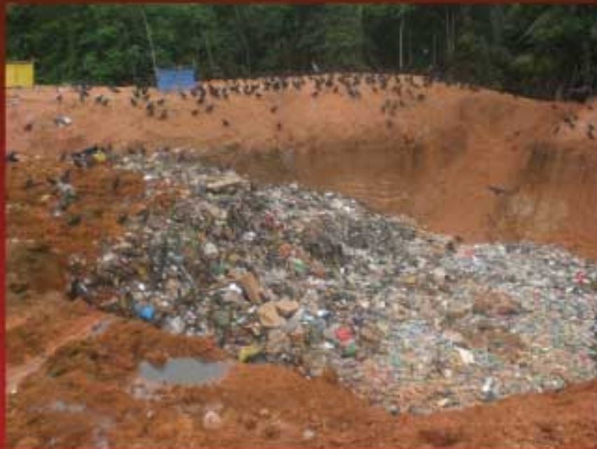
Vertedero Municipal del Cantón Lago Agrio, celda de disposición final, fotografía tomada en Febrero de 2010. Se observa la ausencia de políticas de GIRS: disposición indiferenciada sin control de lixiviados ni biogas.
