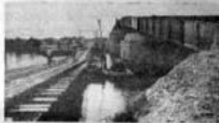
El puente que se inaugura este mes en la calle Portete.
