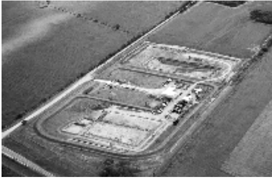
Fig. 10 Vista aérea de la planta de almacenamiento de residuos peligrosos de Taym en la zona de Bouwer Foto: R. Montenegro.
