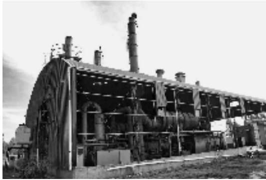
Fig. 8 Incinerador de residuos patógenos junto al vertedero de Bouwer, parcialmente desmantelado
