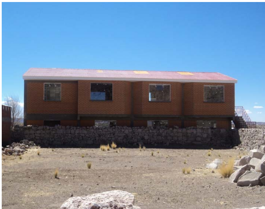
Foto, 3. Construcción de la Sede Social del ayllu Collana, realizada entre 2009-2010.
