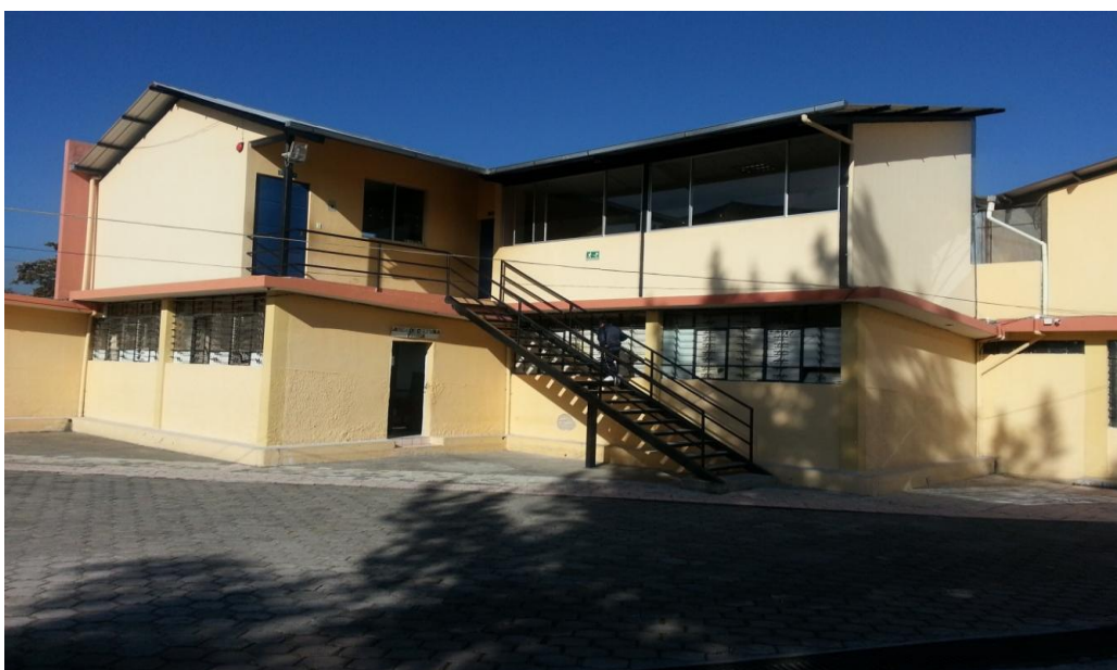
Foto 1 En la planta baja se puede notar dos aulas en la una será la oficina donde va estar la Coordinadora del CAANE organizando las actividades diarias y en la otra el aula del CAANE es donde van asistir los niños con Necesidades Educativa Especiales
