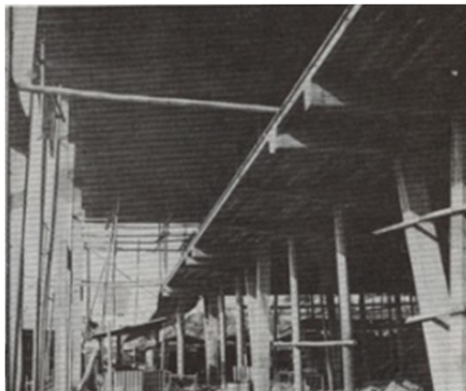
Figura 60. Construcción de la plaza
