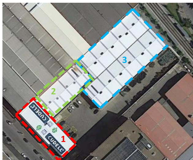
Fig. 31 -Fotografia aérea do imóvel com a identificação dos seus diferentes corpos
