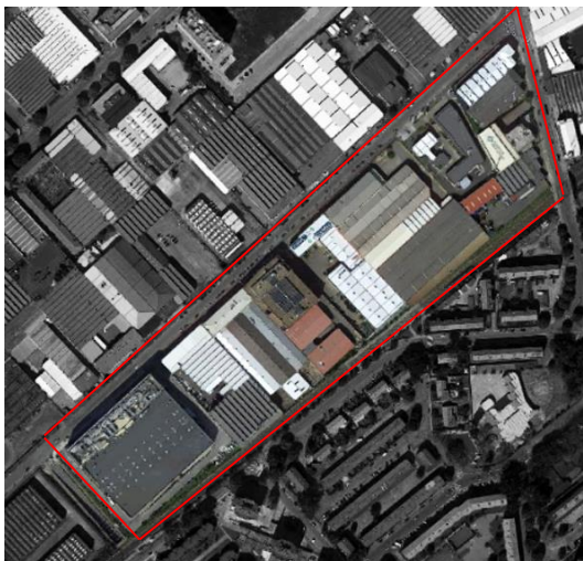
Fig. 28 - Fotografia aérea com indicação, a vermelho, do quarteirão onde se insere o imóvel a reconverter
