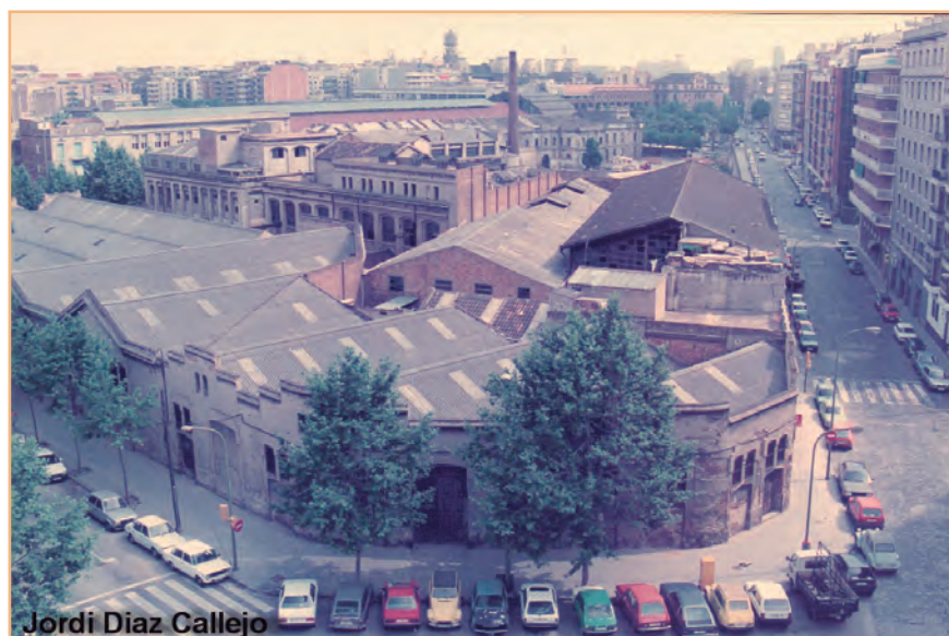
FIGURA 6. Imatge del conjunt fabril de la Refinería de San Luis a finals de la dècada del 1980.
