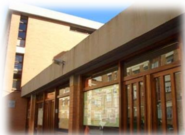
Figura 8. Escola Gaudí de Sabadell. (Fotografia extreta de la pàgina web: ( http://www.xtec.cat/escolagaudisabadell/ )).
