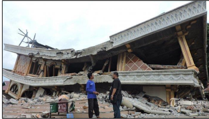
Gambar II.8 Kerusakan akibat bencana gempa bumi di Aceh (Tribunnews, 2016)
