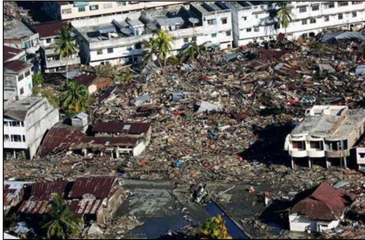
Gambar II.9 Kerusakan akibat bencana tsunami di Aceh tahun 2004 (Kompasiana, 2016)
