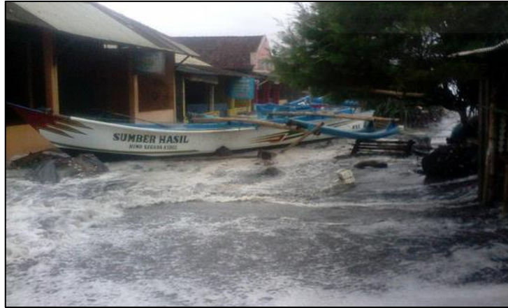
Gambar II.13 Kerusakan akibat gelombang ekstrem dan abrasi (Tobasatu, 2016)
