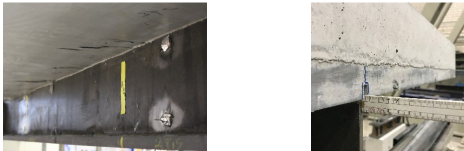
Bild 9: Betonausbrüche im Verbundmittelbereich an der Betonunterseite (links) und der Schlupf der Verbundfuge am Rand des Verbundträgers im Versuch „Endzustand“ (rechts)
