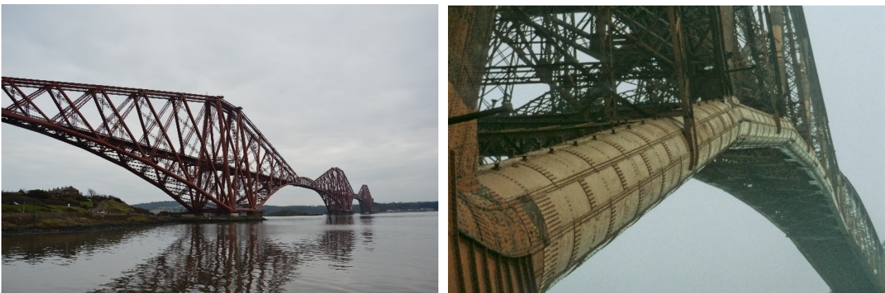
Bild 3: Forth Bridge über den Firth of Forth / Queensferry
