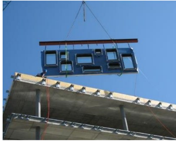
Bild 2: Montage der Fassadenelemente (Cocoon)
