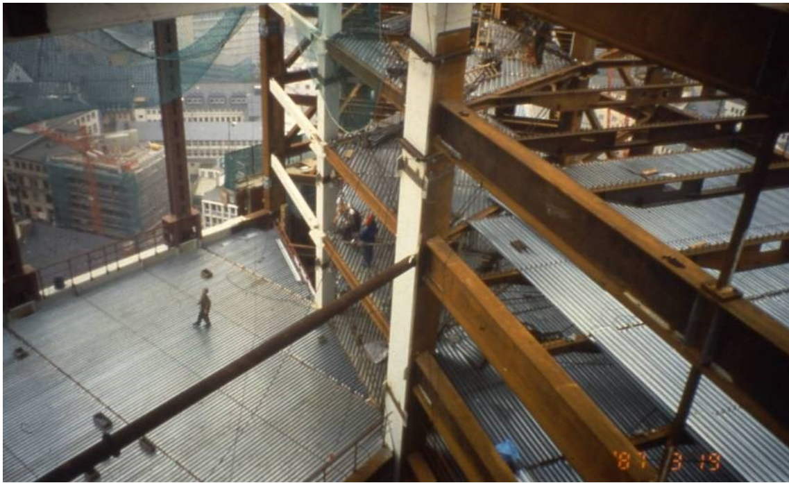
Bild 3: Stahlprofilbleche als tragende Schalung und begehbare Arbeitsfläche (Neubau Commerzbank, Frankfurt)
