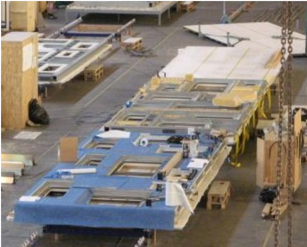
Bild 1: Fertigung von Fassadenelementen in Stahl-Leichtbauweise (Cocoon)
