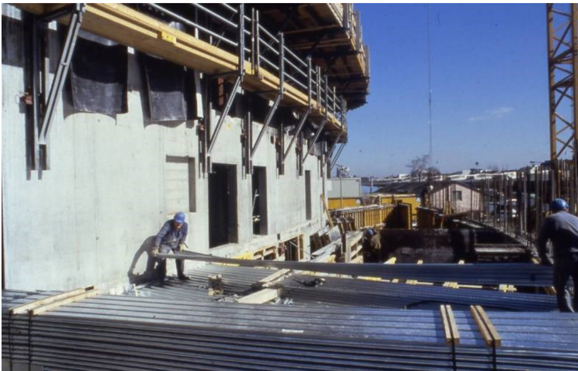
Bild 4: Verlegung von Hand (Messeturm Frankfurt)
