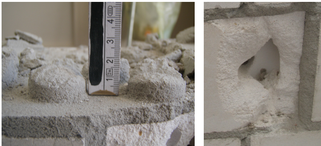
Bild 4.20: Verfüllung der Hohlkammer im Mauerwerk (KSL 2DF)
