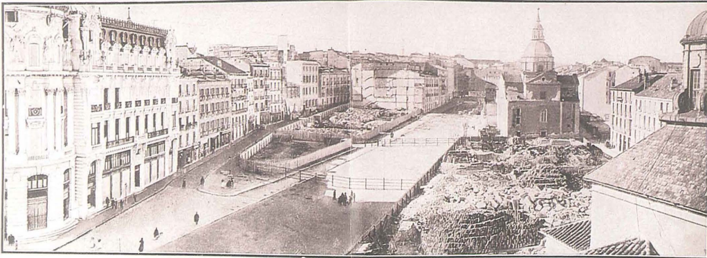
Vista panorámica del terreno que ha de ocupar el primer trazo de la Gran Vía y estado actual de las obras de demolición, en su aspecto desde la calle de Alcalá
