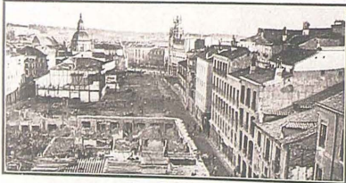
Las obras de la Gran Vía vistas desde la calle de Hortaleza
