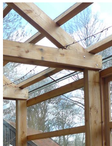
Afb. Constructie serre met houten glas facade
