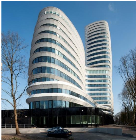
Foto 1: Engelse kamp, Kempkensbrug Groningen
