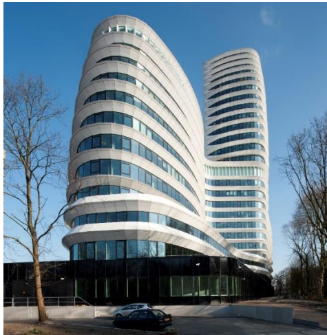
Foto 1: Engelse kamp, Kempkensbrug Groningen
