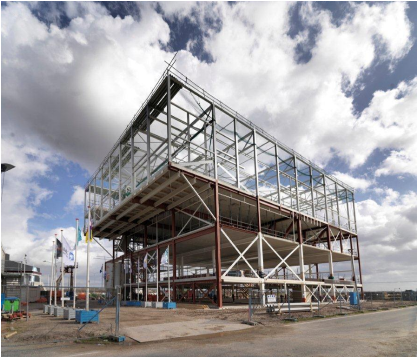
Afbeelding 4: Bouw van een gecombineerde sporthal en zwembad in Almere-Poort
