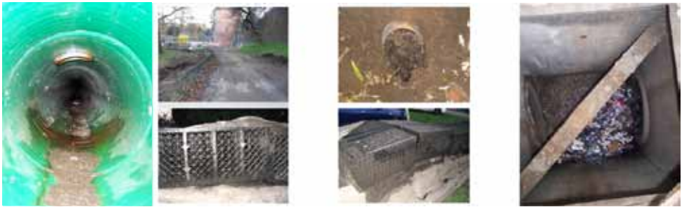
Figuur 5: Aansluitingen zonder kolken/zandvang in Amsterdam en infiltratievoorzieningen in Nijmegen met sediment en straatvuil.
