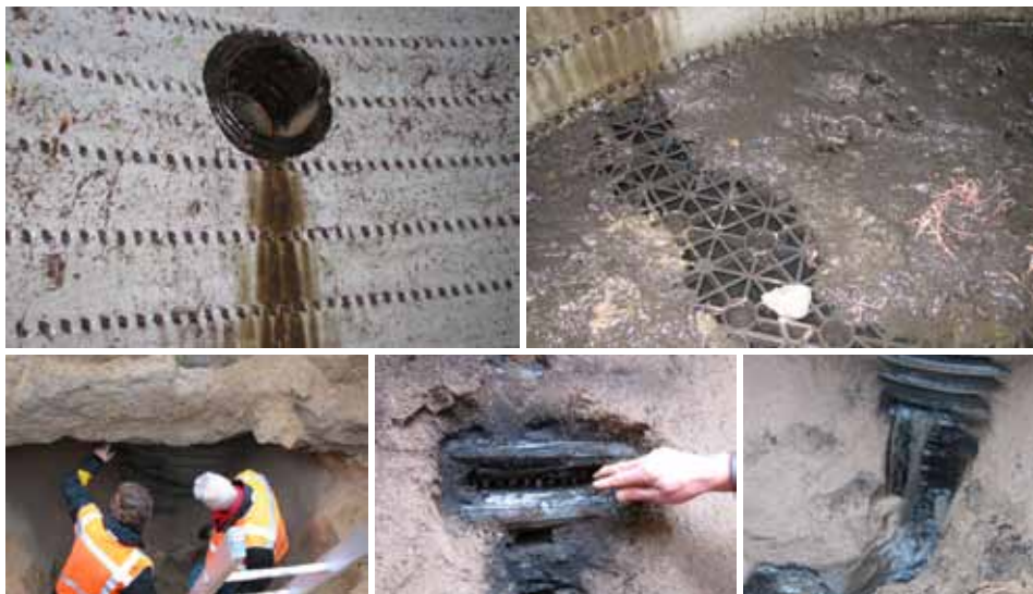
Figuur 10: Praktijkonderzoek zakput in Renkum.
