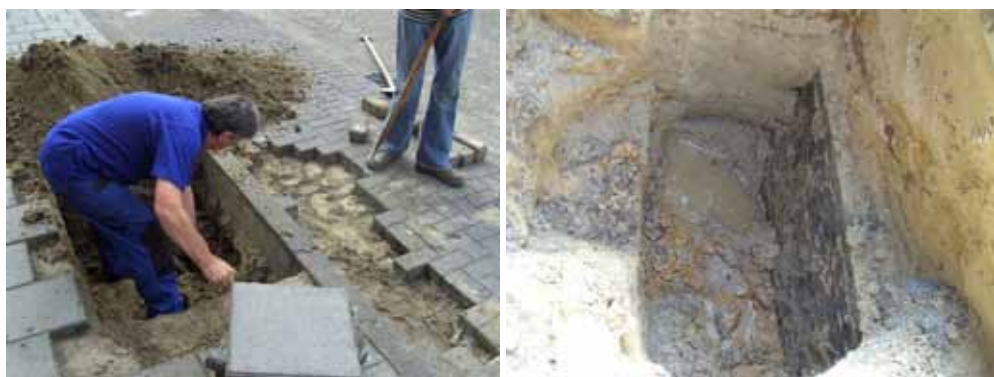
Figuur 11: Praktijkonderzoek infiltratiekratten Eindhoven in de Runstraat.
