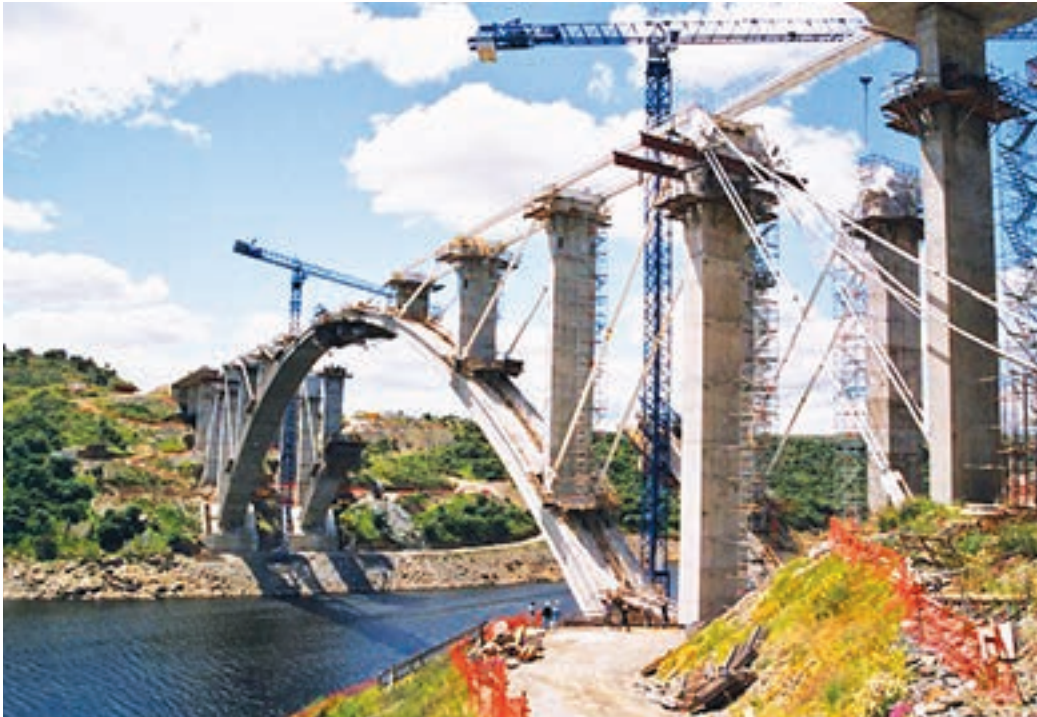
Figura 6.2 Puente de arco de Almonte en ejecución de la obra. Fuente: Salvadori y H. (julio 2017)
