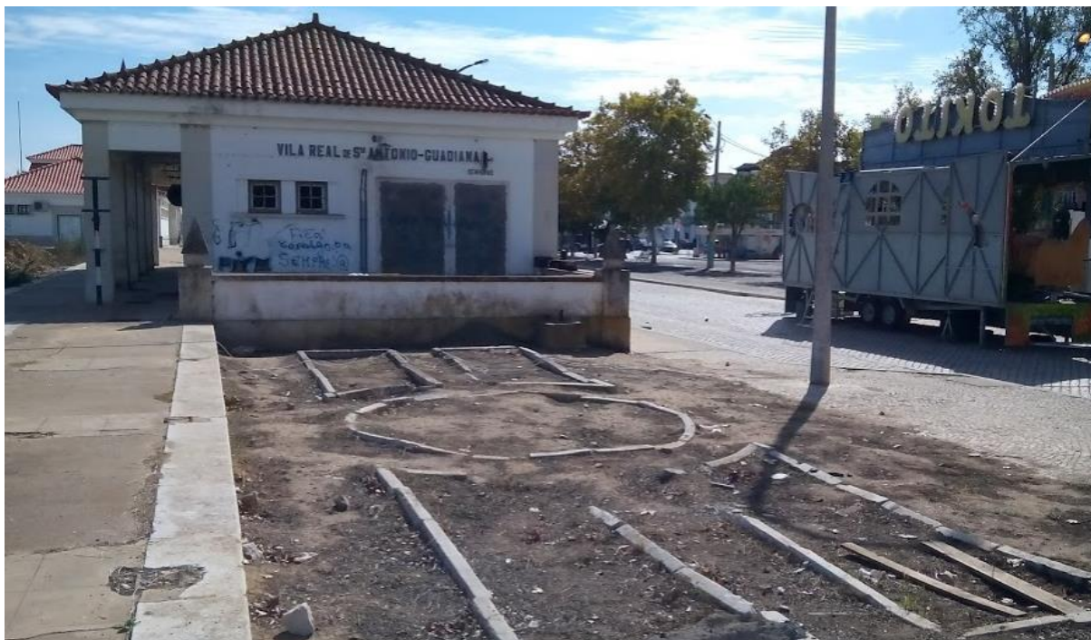
Figura 12 – Estação encerrada do caminho de ferro de VRSA (Fonte: Autor).
