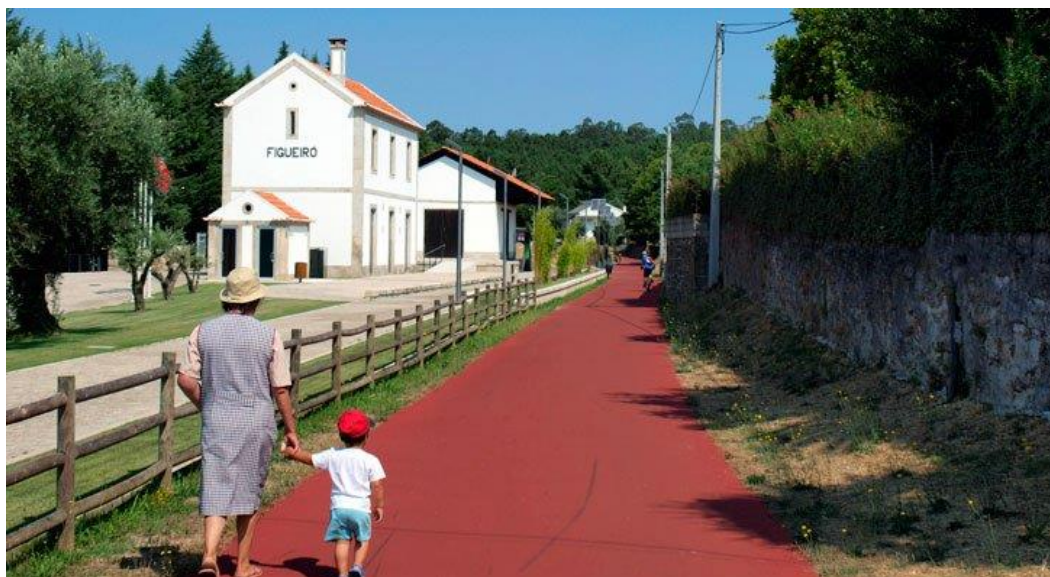
Figura 28- Ecopista do Dão (“ Infraestruturas de Portugal - Património ,” n.d.)
