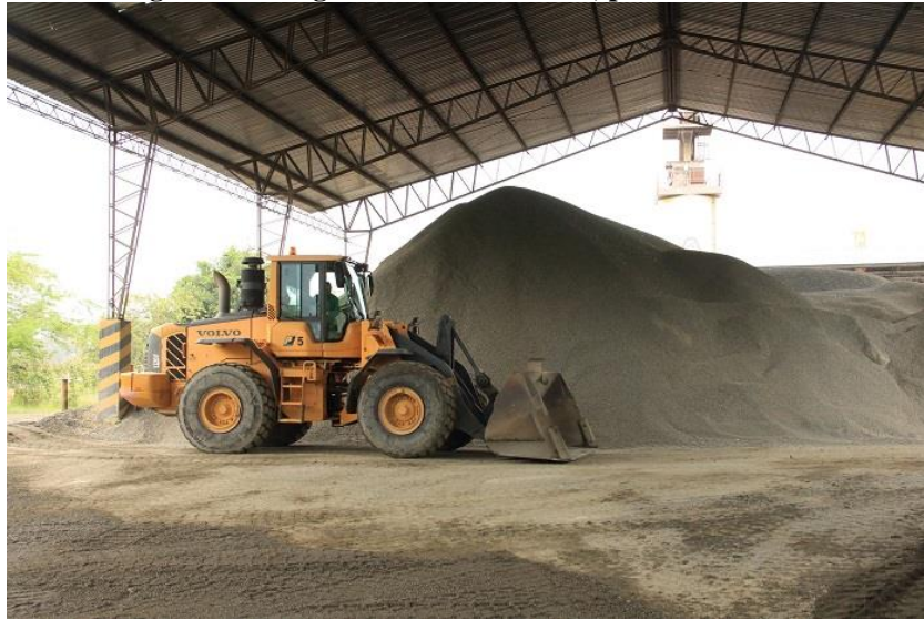
Figura XI. Cargador de alimentación, planta de asfalto
