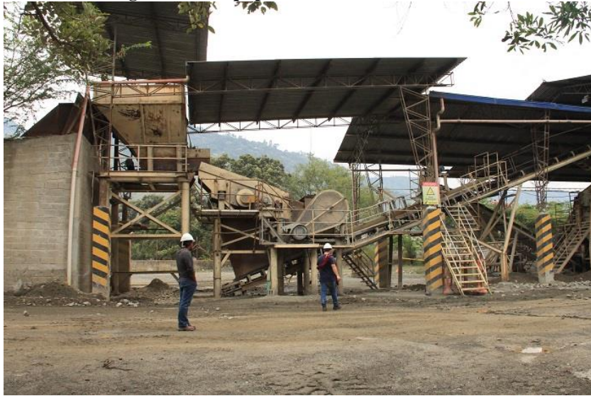
Figura VIII. Equipo de trituración de material
