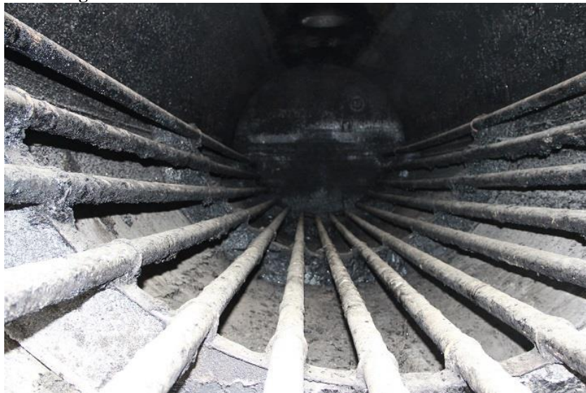
Figura XII. Detalle del sistema de calentamiento del asfalto
