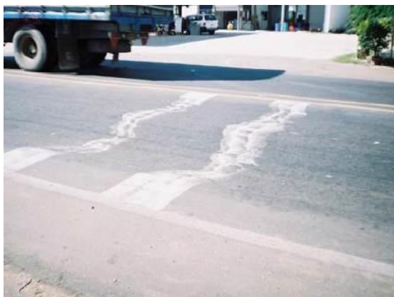
Figura 8. Ahuellamiento
