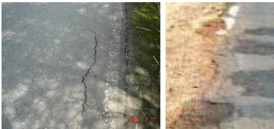
Figura 17. Desintegración de bordes
