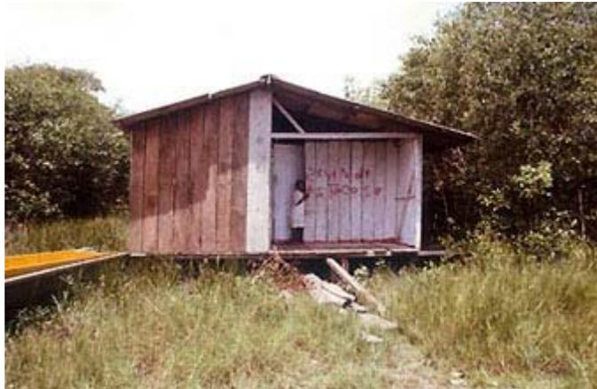
En la imagen 1.1 se presenta una construcción de vivienda con cerramientos contruidos en madera, cubierta en teja de eternit y piso en madera. Aparentemente la vivienda tiene un área mayor que las viviendas de los asentamientos de desplazados.
