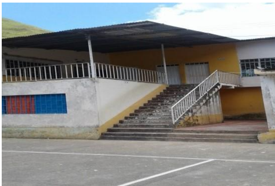
Figura 2. Institución Educativa La Reforma- Área de Bachillerato
