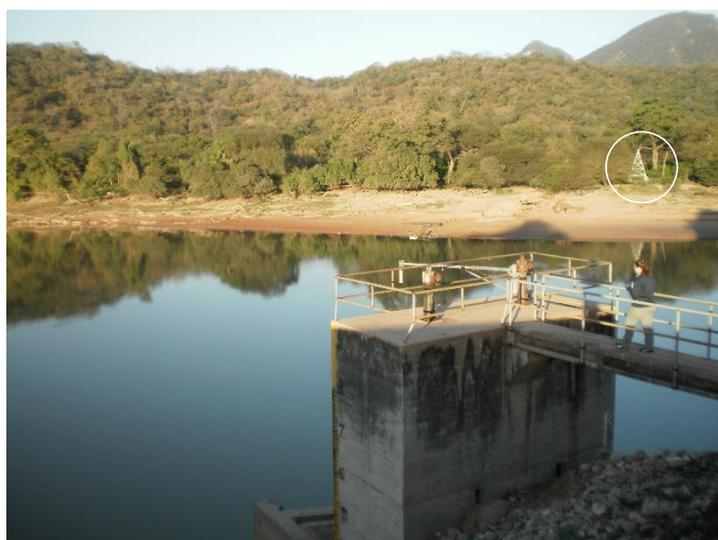
**Figura 39.-** Sensor Kalesto y Torre de sección de aforo julio 2014 (Cristanchi & Testa Tacchino, 2014).
