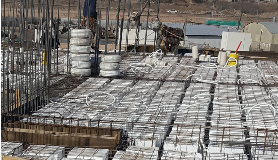
Figura 74 - Tendido de caños corrugados
