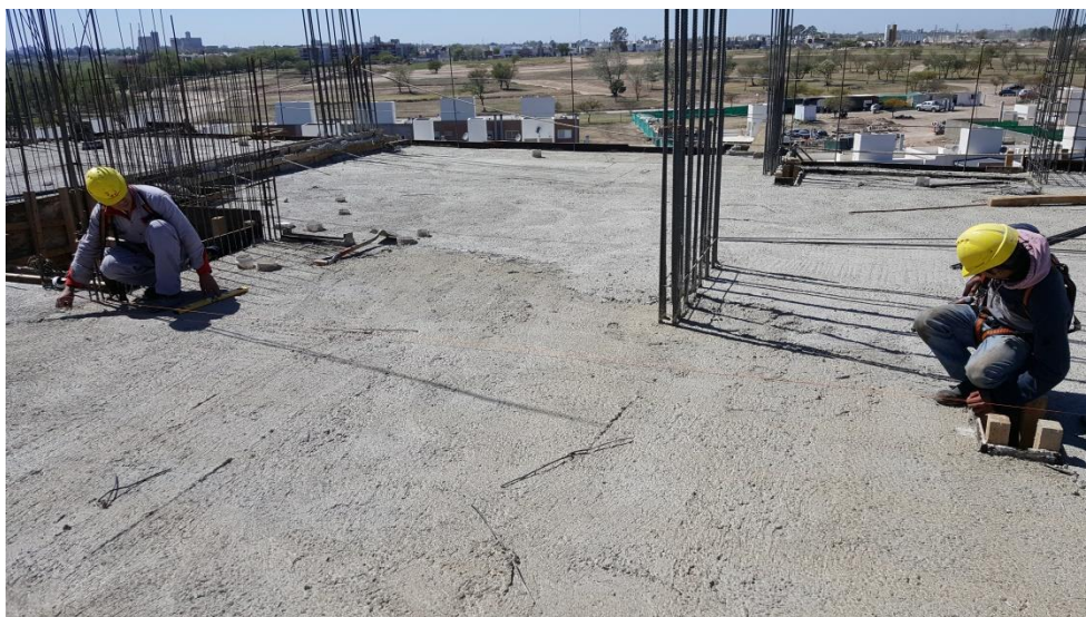
Figura 37 - Obreros replanteando los ejes
