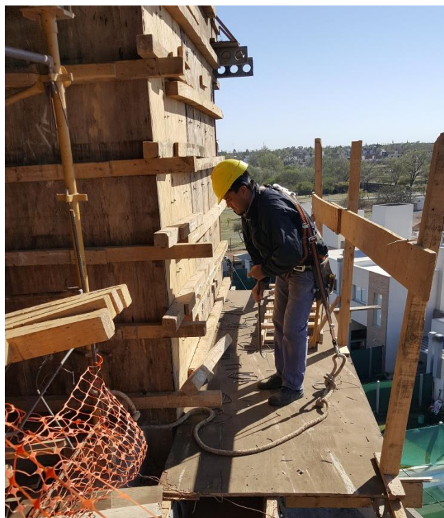
Figura 17 - Obrero trabajando sobre plataforma de ancho superior a 60 cm con barandas y atado a cuerda de vida
