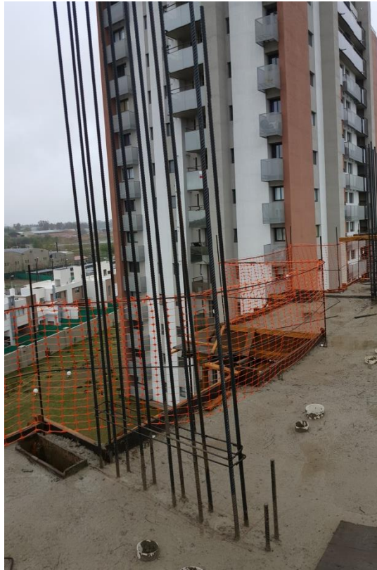
Figura 38 - Columna replanteada
