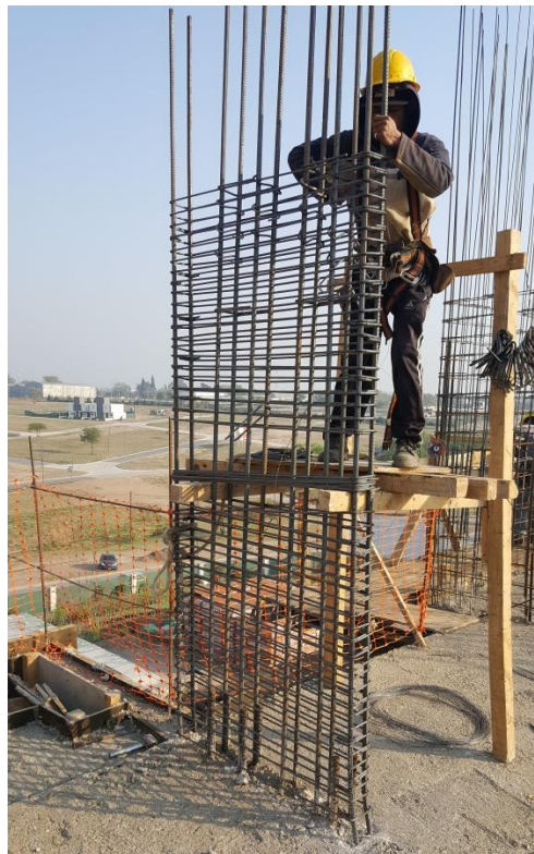
Figura 42 - Obrero atando estribos
