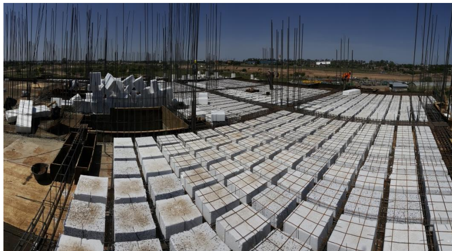
Figura 72 - Mallas electro soldadas sobre molones formando la armadura de compresión
