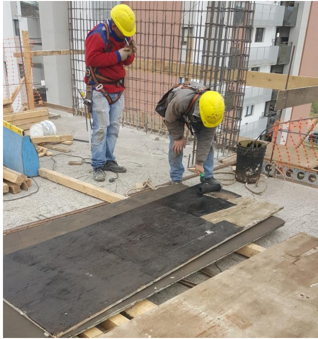
Figura 43 - Pintando fenólicos para encofrado
