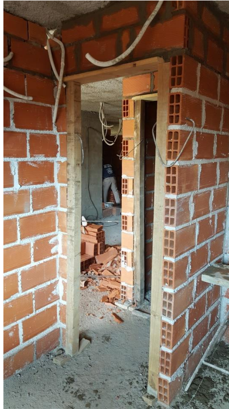
Figura 94 - Encofrado de abertura
