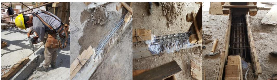
Figura 83 - Proceso de reparación
