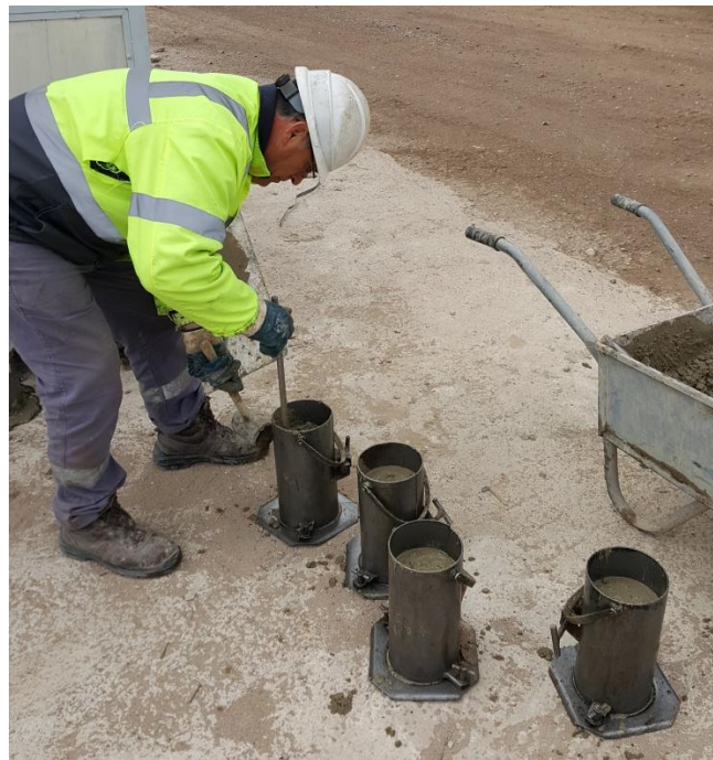
Figura 35 - Personal de Holcim preparando las probetas
