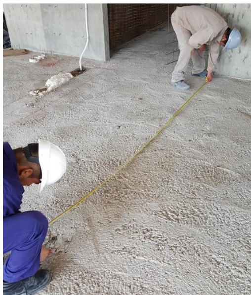
Figura 87 - Obreros replanteando los muros
