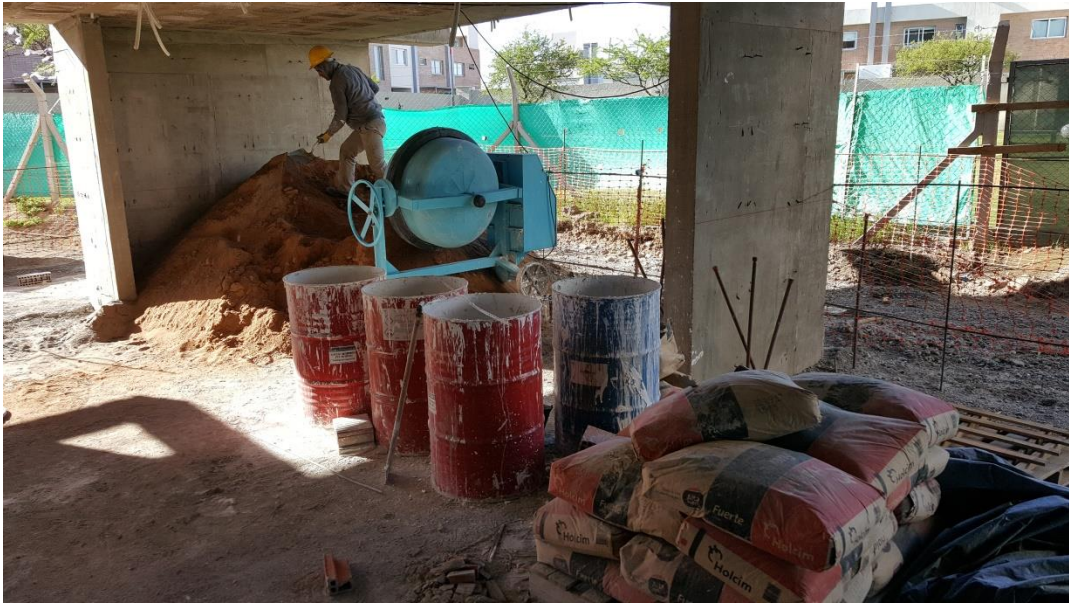
Figura 8 - Acopio de materiales para la preparación de mortero
