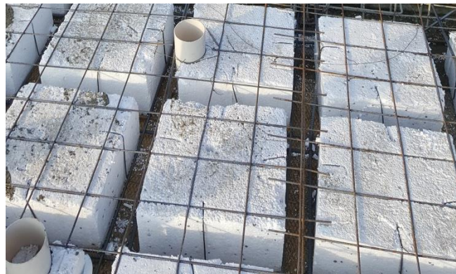
Figura 76 - Pases sanitarios materializados con tubos de PVC
