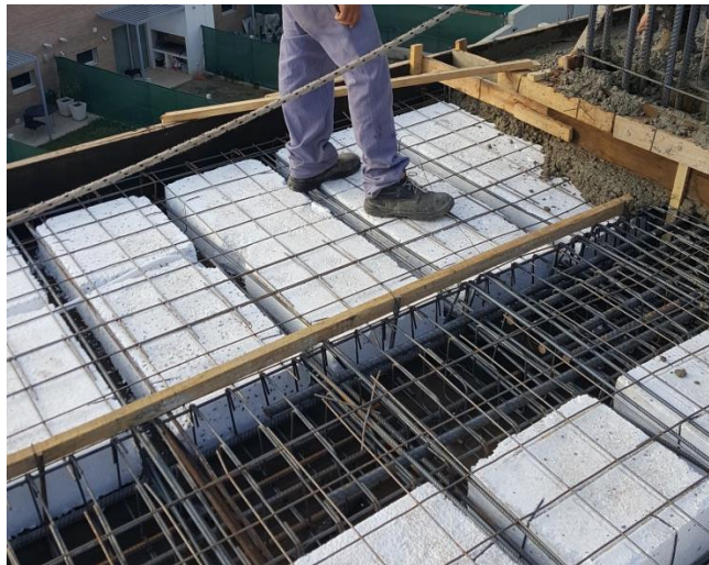
Figura 64 - Encofrado para losas de distinto espesor
