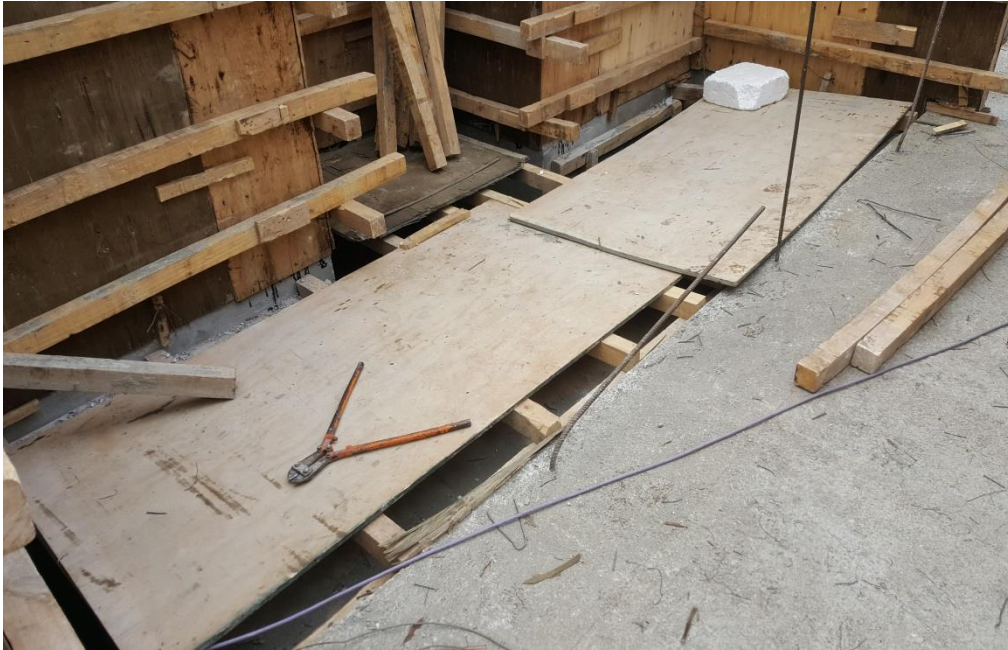
Figura 23 - Fenólico tapando hueco del ascensor con soleras de 3"x3"
