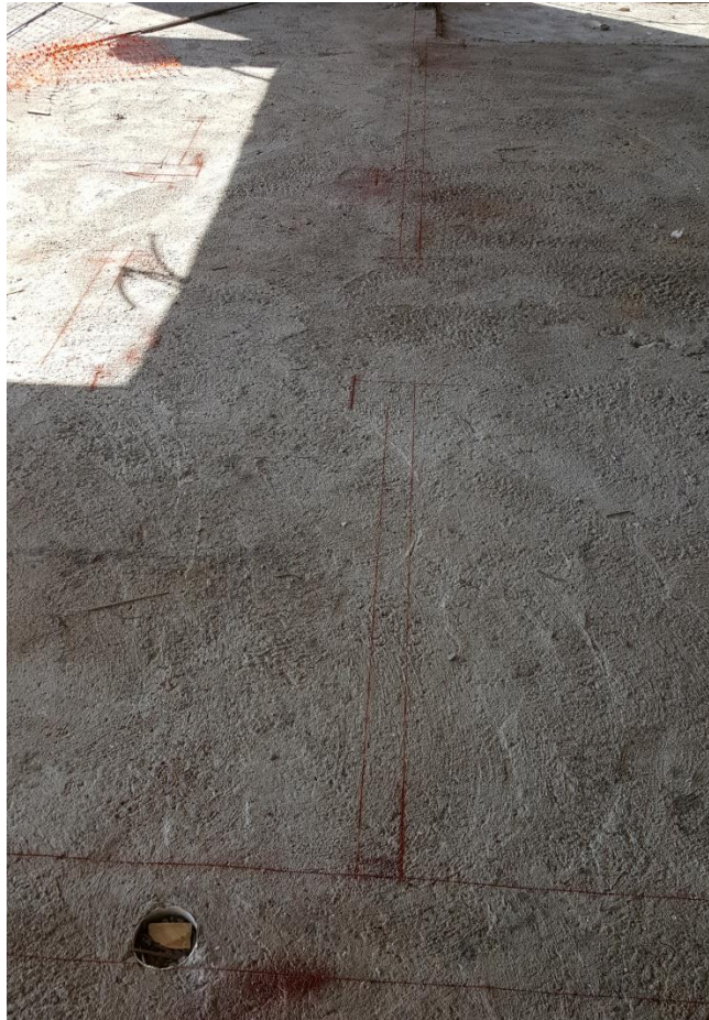
Figura 88 - Muros ya replanteados
