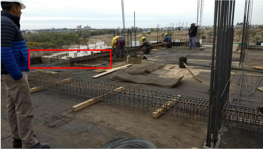
Figura 63 - Armado de Vigas ya con cierres borde de losa
