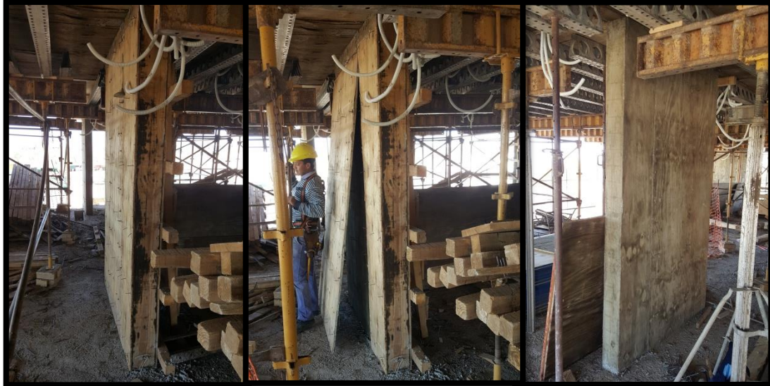
Figura 55 - Pasos para el desencofrado
