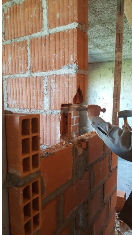
Figura 97 - Picando la mampostería para realizar correctamente el encuentro
