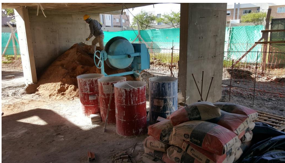
Figura 92 - Zona de preparación de mortero
