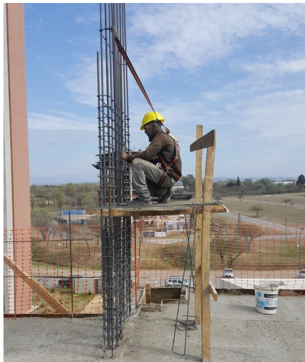
Figura 19 - Obrero trabajando a distinto nivel sobre plataforma de ancho superior a 60 cm con baranda y atado con su arnés a la columna
