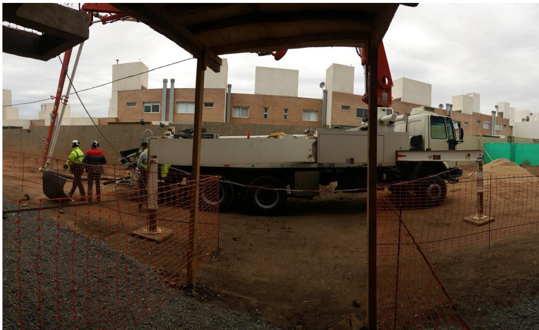
Figura 24 - Ingreso Este a obra con vallado correspondiente
