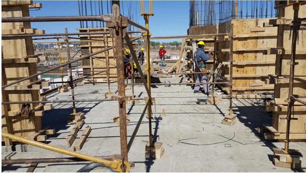
Figura 60 - Armado de camas con cabezales
