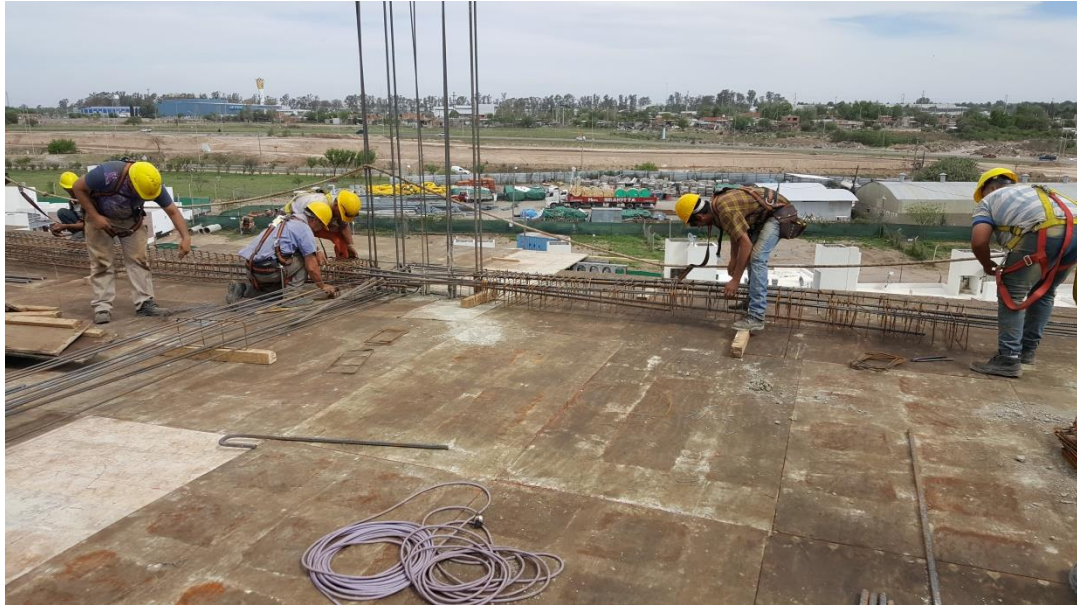
Figura 68 - Comienzo del armado de viga
