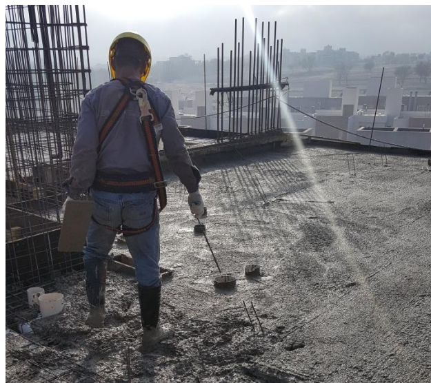
Figura 78 - Fratacho manual y hierro marcado con espesores de losa
