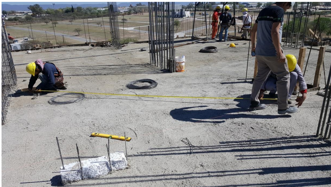
Figura 65 - Verificando perpendicularidad entre ejes con triángulo de Pitágoras con losa ya hormigonada
