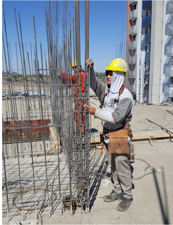
Figura 41 - Tomando nivel con nivel de manguera para marcar la posición del estribo
