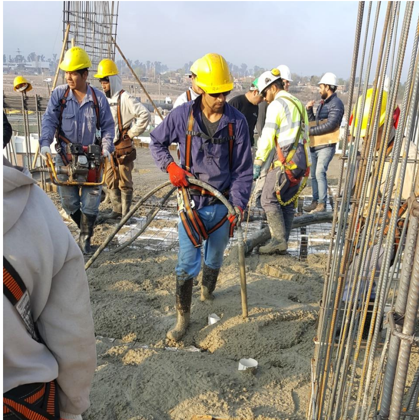
Figura 16 - Obrero con protección ocular (gafas), de las manos (guantes) y protección de la cabeza (casco)
