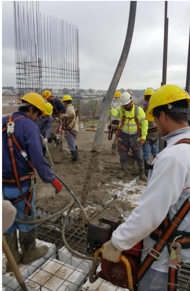
Figura 80 - Hormigonado
