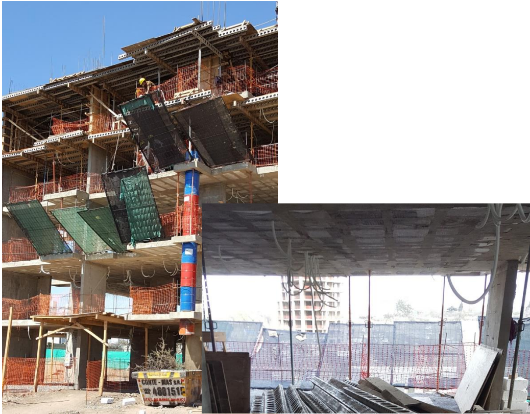
Figura 29 - Traslado de bandejas y bandejas ya colocadas
