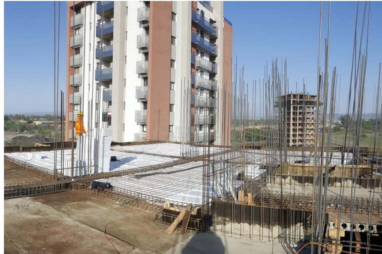
Figura 70 - Comienzo de armado de losas y colocación de molones
