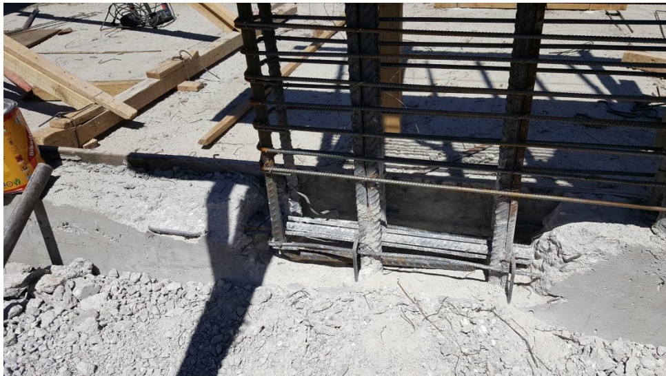
Figura 84 - Proceso de reparación
