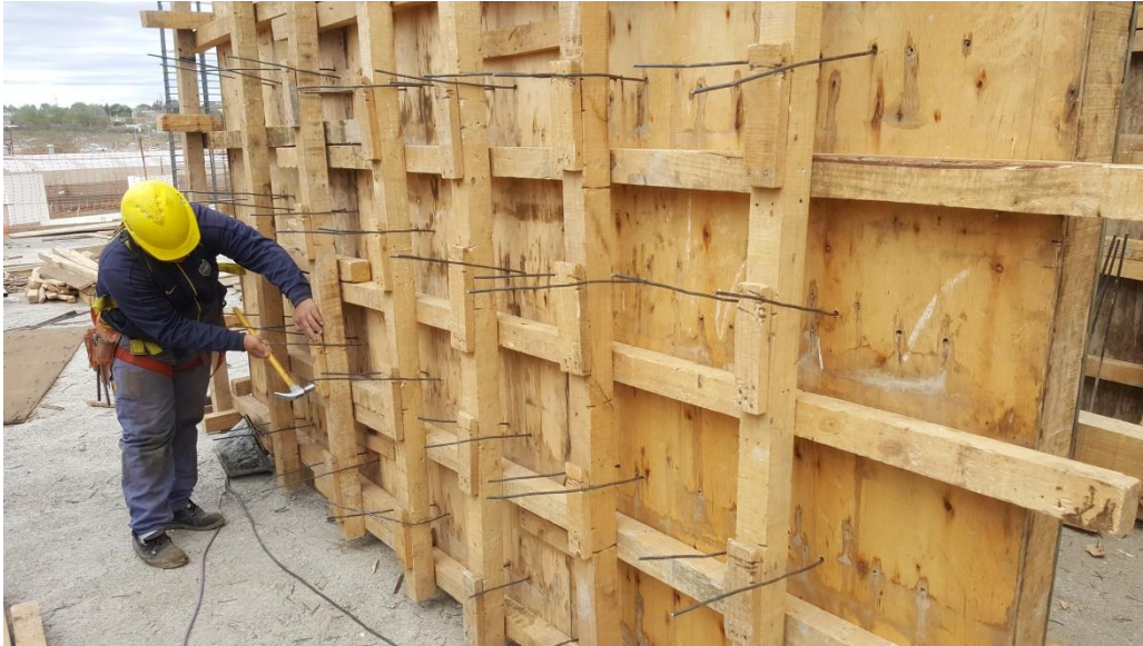
Figura 45 - Tabique con perforaciones y hierros para amarre
