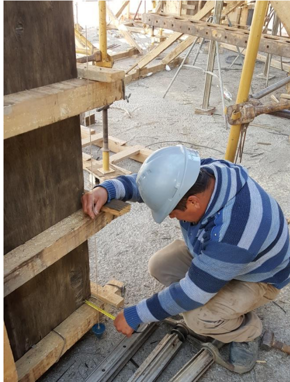
Figura 49 - Personal de EDISUR controlando verticalidad de una columna
