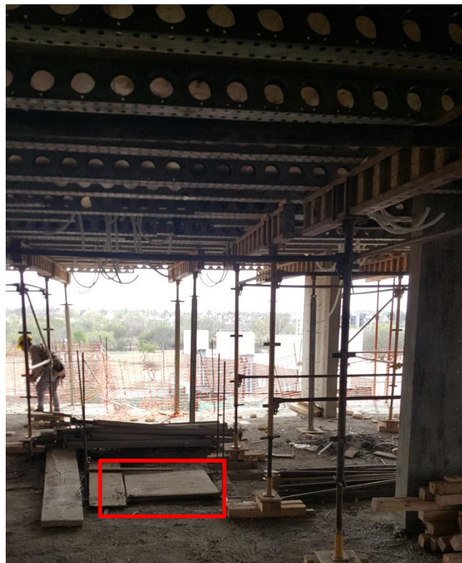
Figura 22 - Fenólico tapando un hueco de montante
