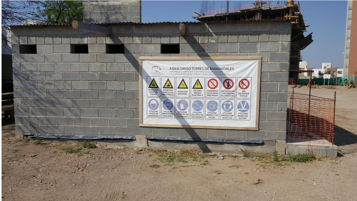
Figura 27 - Cartel con los riesgos y los EPP en el ingreso a obra
