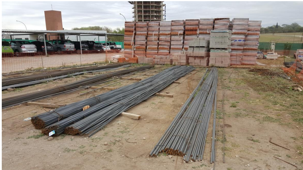
Figura 11 - Cancha de hierros junto a acopio de mampuestos
