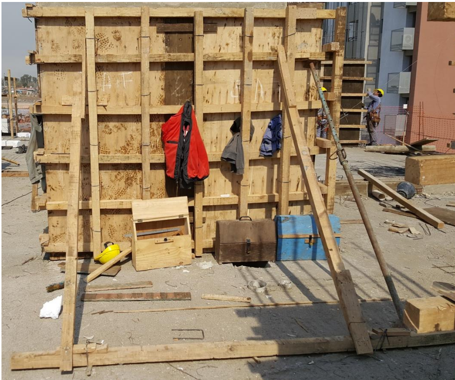
Figura 47 - Tabique con aviones colocados
