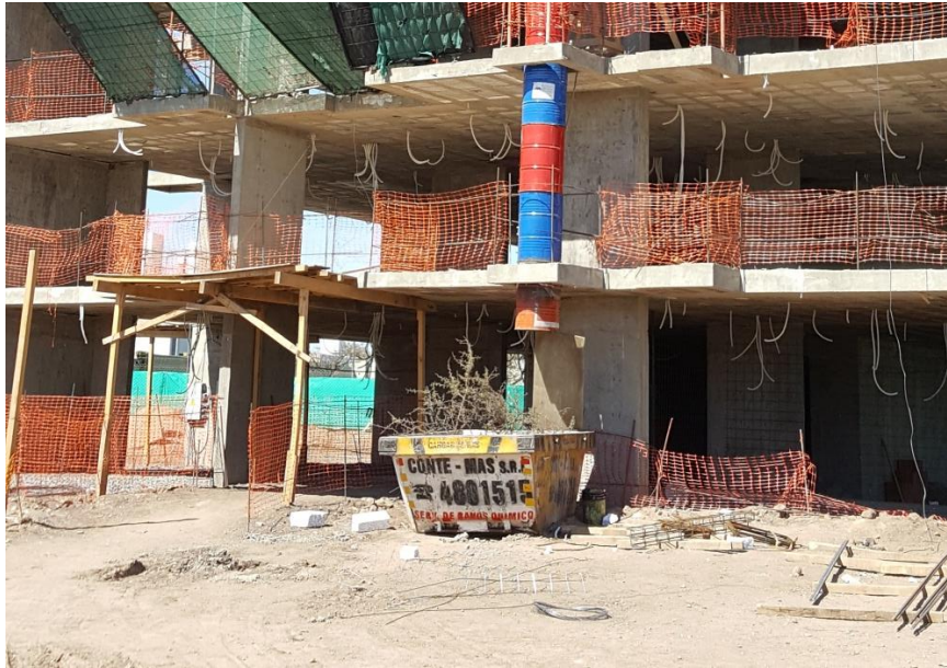
Figura 26 - Ingreso Norte a obra con vallado correspondiente
