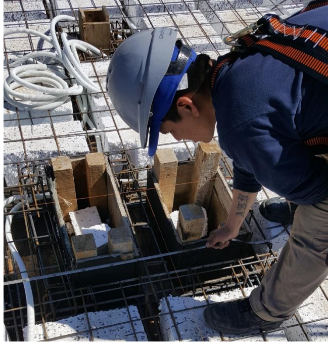
Figura 73 - Montantes encofradas
