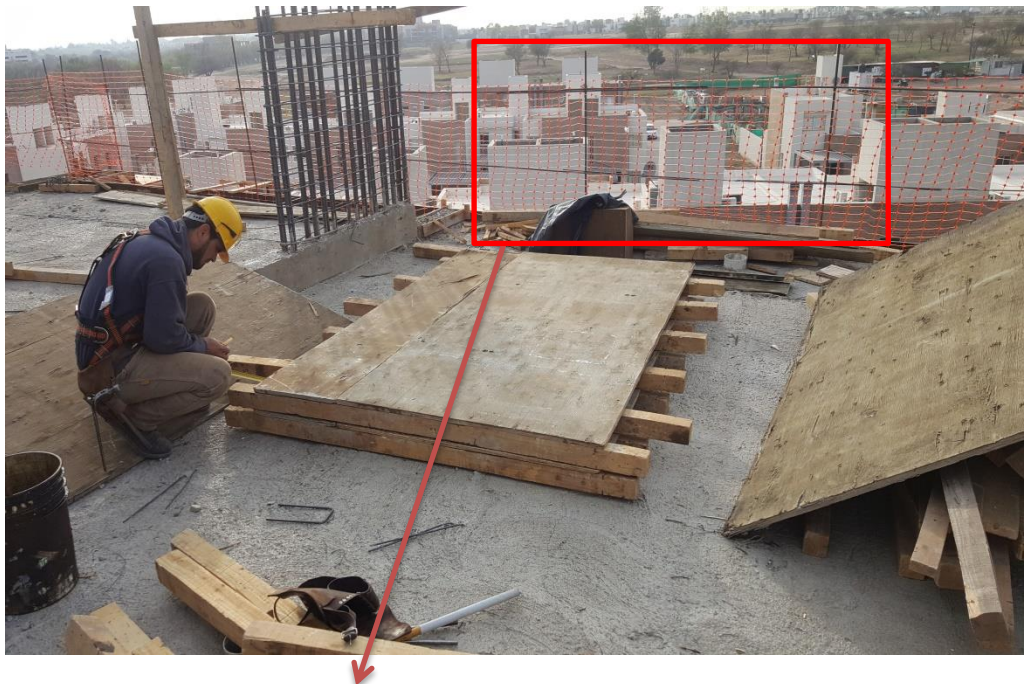
Figura 20 - Baranda de seguridad con malla perimetral de plástico naranja
