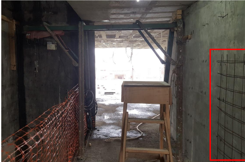
Figura 21 - Malla electrosoldada que protege el hueco del ascensor y el guinche para mampostería. Momentáneamente retirada para la instalación del mismo
