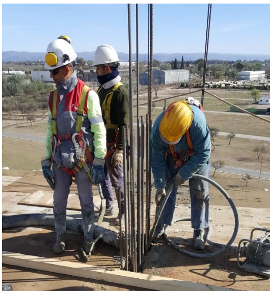
Figura 54 - Obrero vibrando la columna
