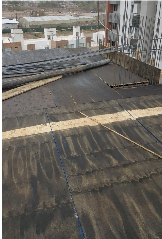
Figura 62 - Fenólicos colocados sobre las camas y cierre con tabique
