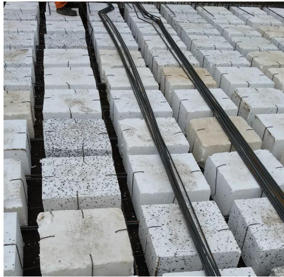
Figura 71 - Molones sostenidos por ranitas y armaduras para nervios de losa
