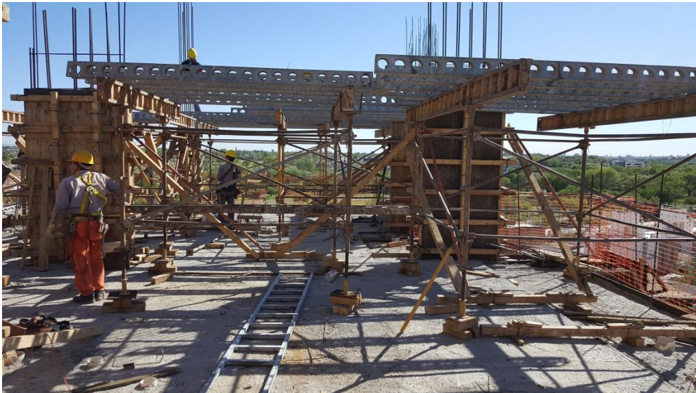
Figura 61 - Camas con vigas y cabezales
