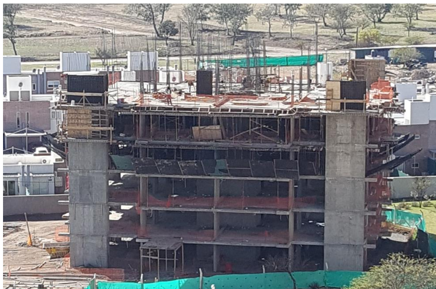
Figura 25 - Ingreso Oeste a obra con vallado correspondiente
