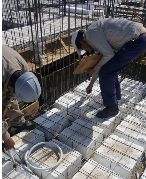
Figura 75 - Replanteo de pases sanitarios
