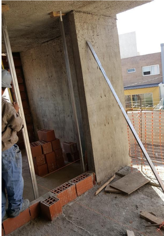
Figura 91 - Parado de reglas y colocado de tanzas para la próxima hilada
