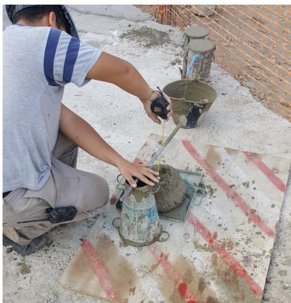
Figura 34 - Pañolero midiendo el asentamiento
