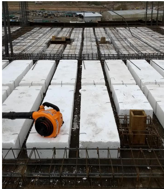
Figura 56 - Losas armadas en 1 y 2 direcciones
