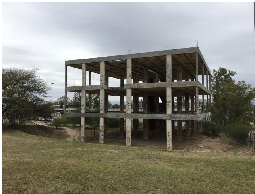
Figura 2.2: Estructura de hormigón armado existente.
