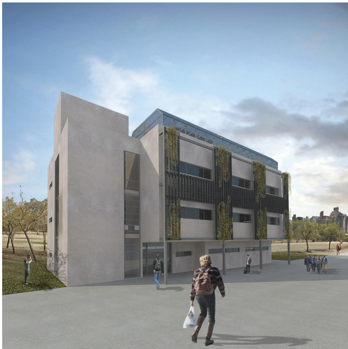
Figura 5.11: Vista peatonal de la fachada Sur.
