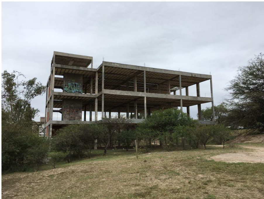
Figura 2.1: Estructura de hormigón armado existente.
