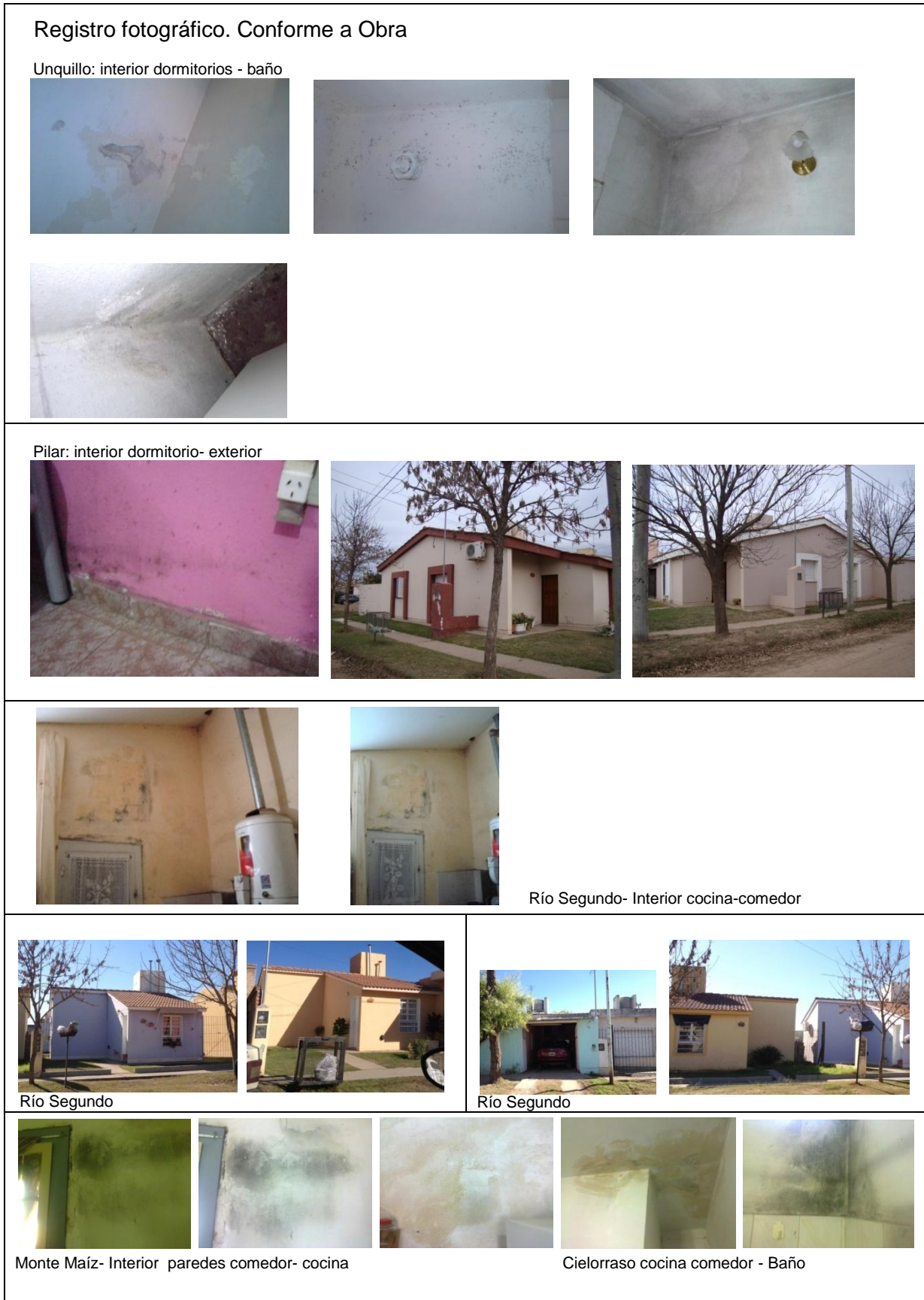
Fig. 14. Registro fotográfico. Conforme a obra- Elaboración Propia
