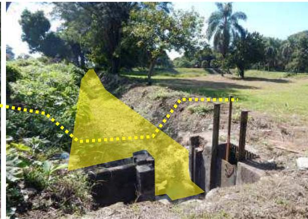
Falta de mantenimiento de canales de agua (acequia oeste), se observa una compuerta de entrada de agua en desuso y mal estado de conservación. (07)
