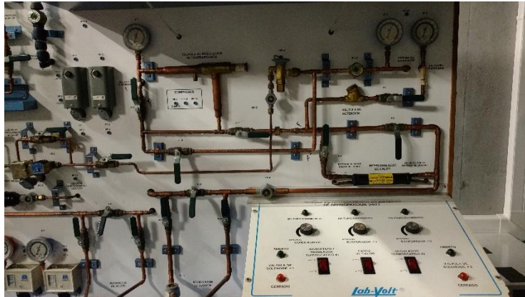
Figura 17. Imágenes de prueba en Entrenador de Refrigeración (continuación).
