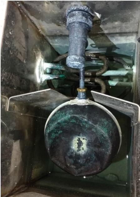
Figura 16. Imágenes de prueba en Entrenador de Aire Acondicionado (continuación).
