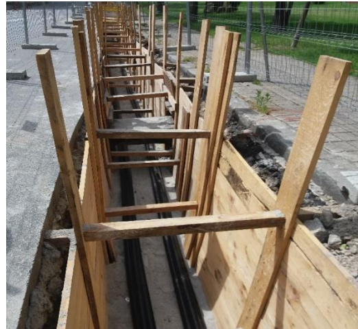
b) Distribuição de cabos na vala
