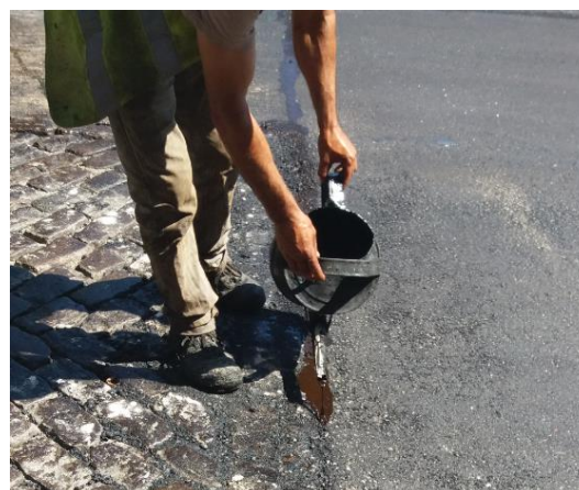
b) Colmatação da junta
