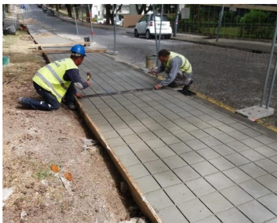
a) Repartição uniforme do betão
