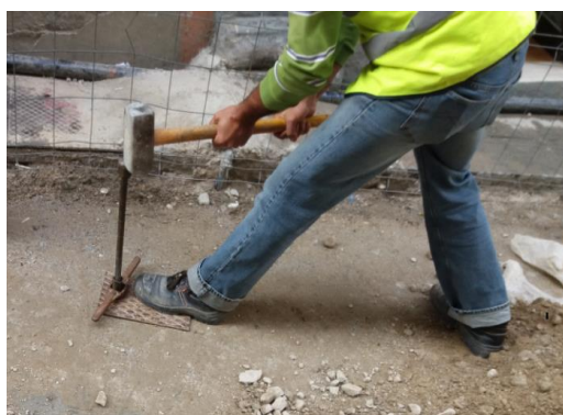
a) Execução do furo na camada
