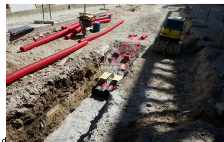
Figura 6.51 – Aterro da vala na rua de Santos de Pousada.
