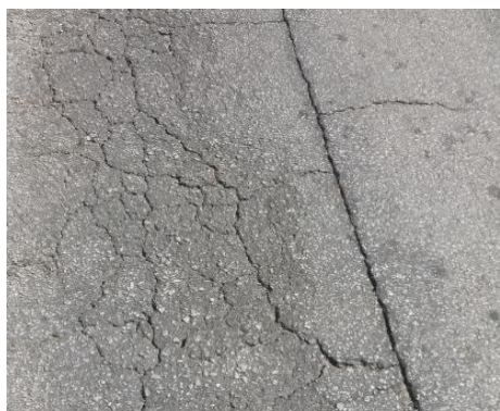
a) Pele de crocodilo e fenda longitudinal
