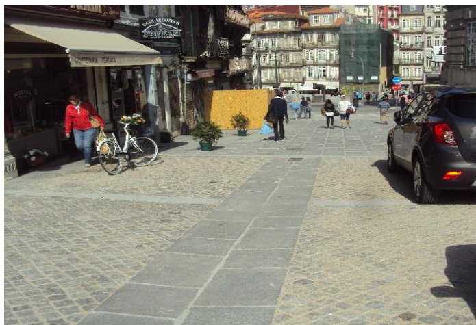
Figura 6.20 – Área intervencionada concluída.
