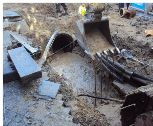
b) Escavação da vala
