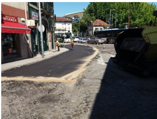
a) Espalhamento da areia
