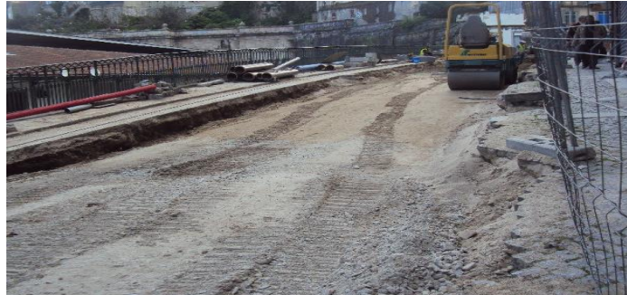
Figura 6.11 – Camada de sub-base e base sobre o leito pavimento.
