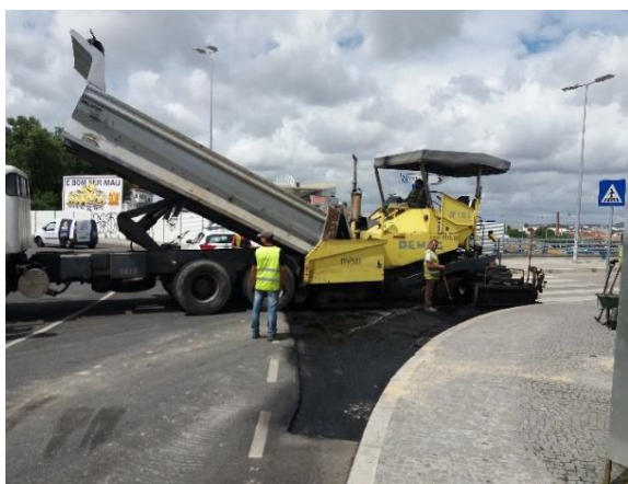
a) Camião acoplado na pavimentadora
