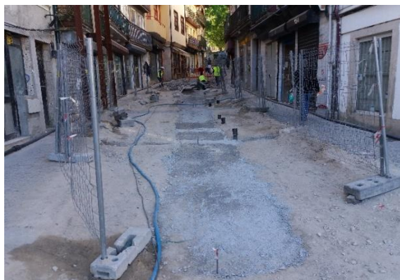
a) Regularização da camada subjacente
