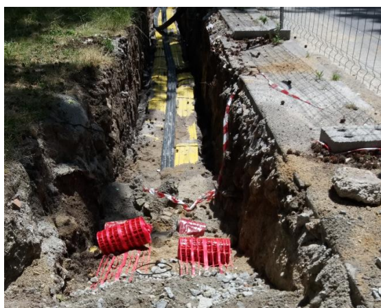
a) Vala aberta
