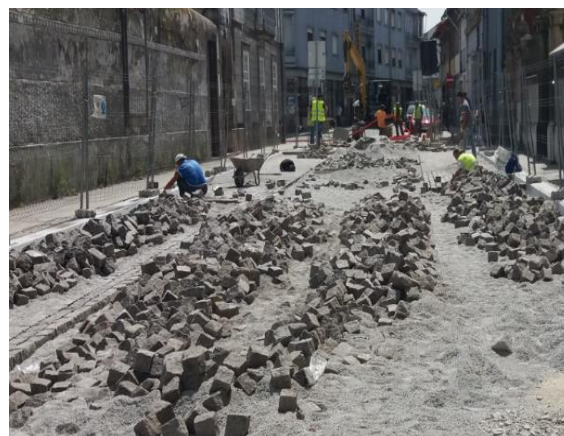
b) Assentamento dos cubos
