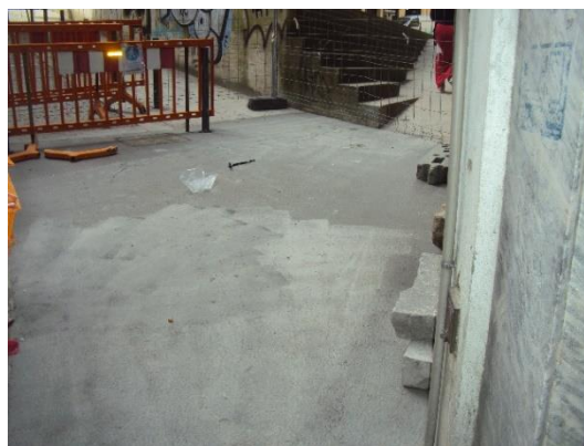
b) Regularização da superfície de desgaste
