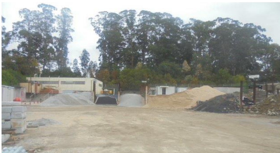
Figura 2.4 – Estaleiro do Monte Aventino.
