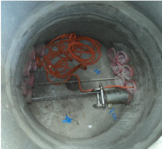
a) Caixa de visita
