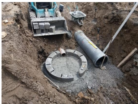
a) Instalação dos coletores
