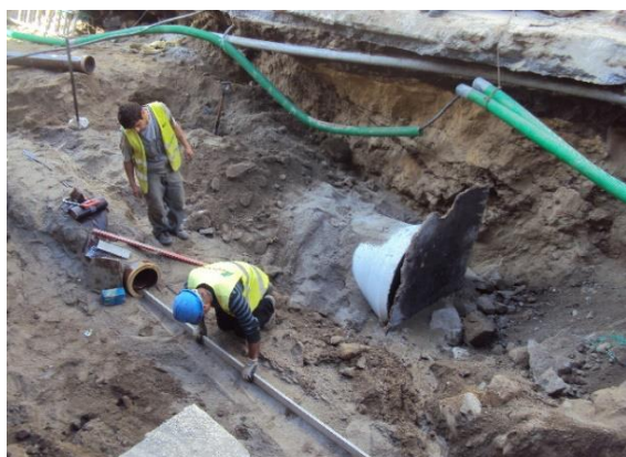
a) Instalação da tubagem de águas residuais e pluviais
