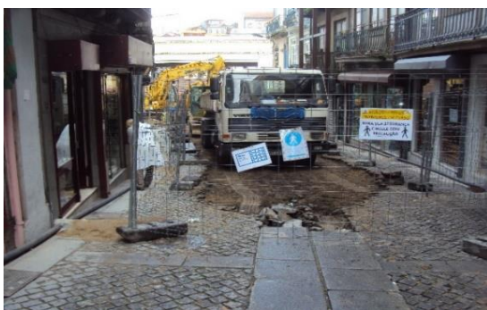
a) Prolongamento da vedação
