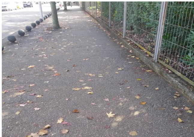
Figura 4.14 – Passeio em material betuminoso.
