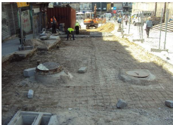
a) Instalação da malha sol
