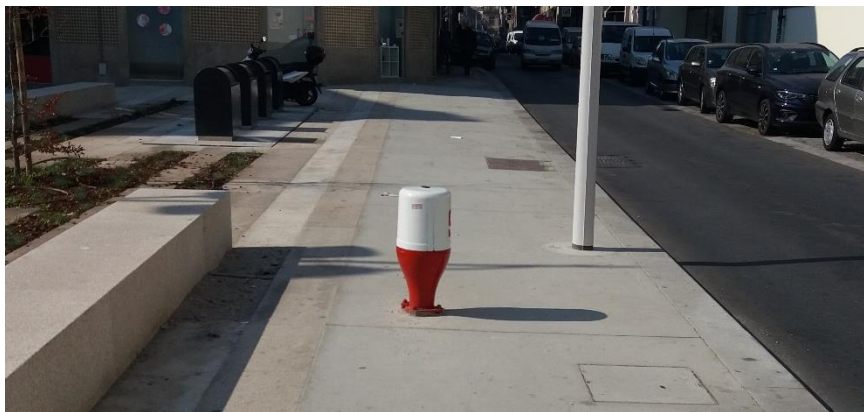
Figura 5.9 – Marco de incêndio mal posicionado.
