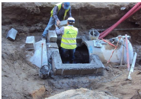
a) Execução da caixa de ligação
