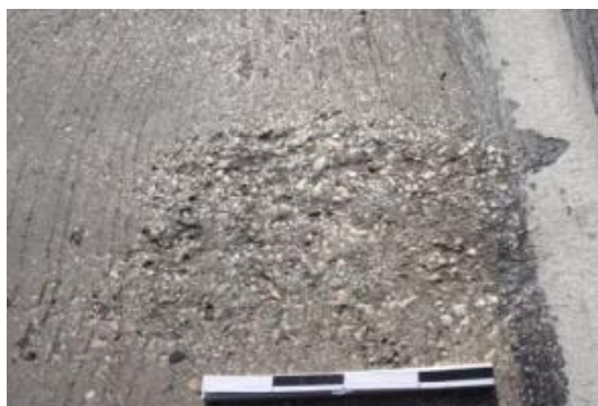
a) Desagregação
