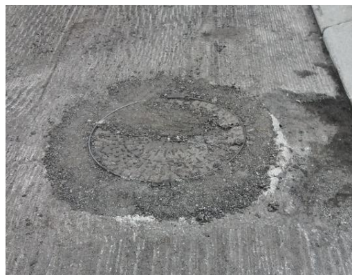
b) Correção de desnível em torno da caixa
