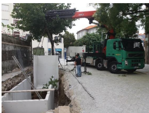
a) Instalação das cubas pré-fabricadas
