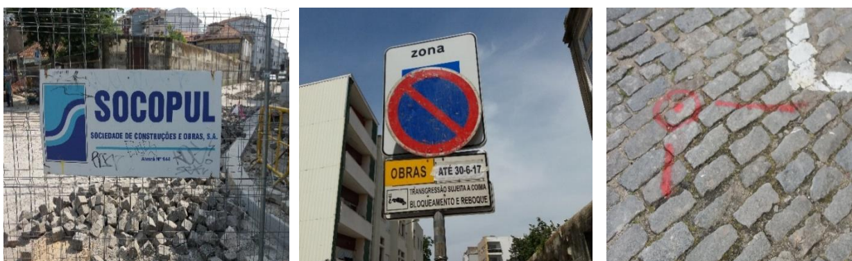
a) Placa de obra
