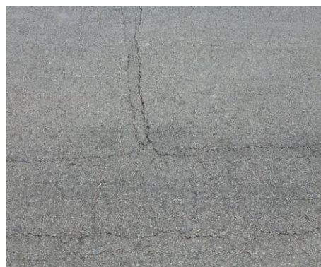
b) Fenda longitudinal e transversal
