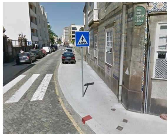
b) Sinal vertical mal posicionado
