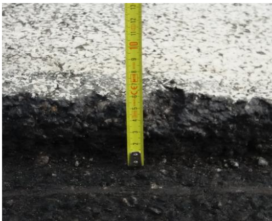
a) Medição da espessura da camada
