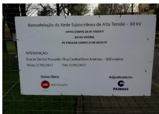
a) Placa de obra
