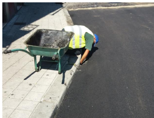
b) Limpeza dos órgãos de drenagem
