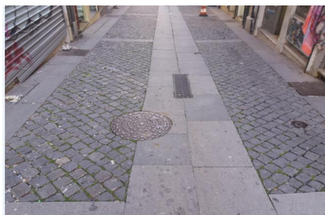
Figura 6.1 – Pavimento existente ao longo do arruamento.
