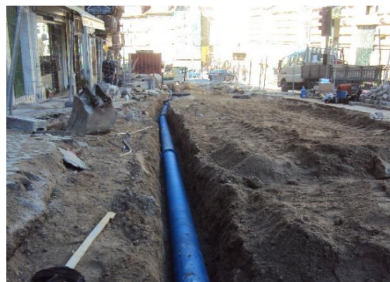
b) Instalação da tubagem de abastecimento de água
