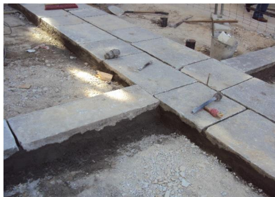
b) Assentamento do lajeado
