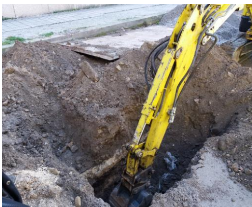
a) Escavação da vala
