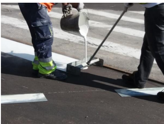
a) Aplicação do material termoplástico
