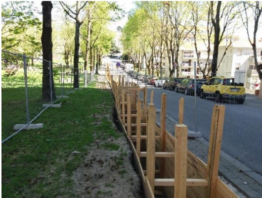
a) Entivação da vala
