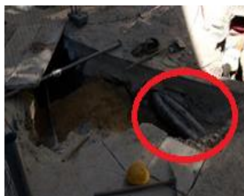
b) Infraestruturas existentes no subsolo
