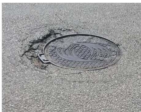
a) Pele de crocodilo e fenda longitudinal
