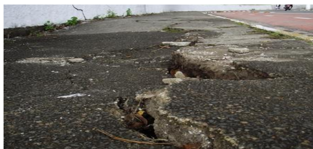
Figura 4.6 – Abatimento do pavimento (fonte: Jacob, 2017).
