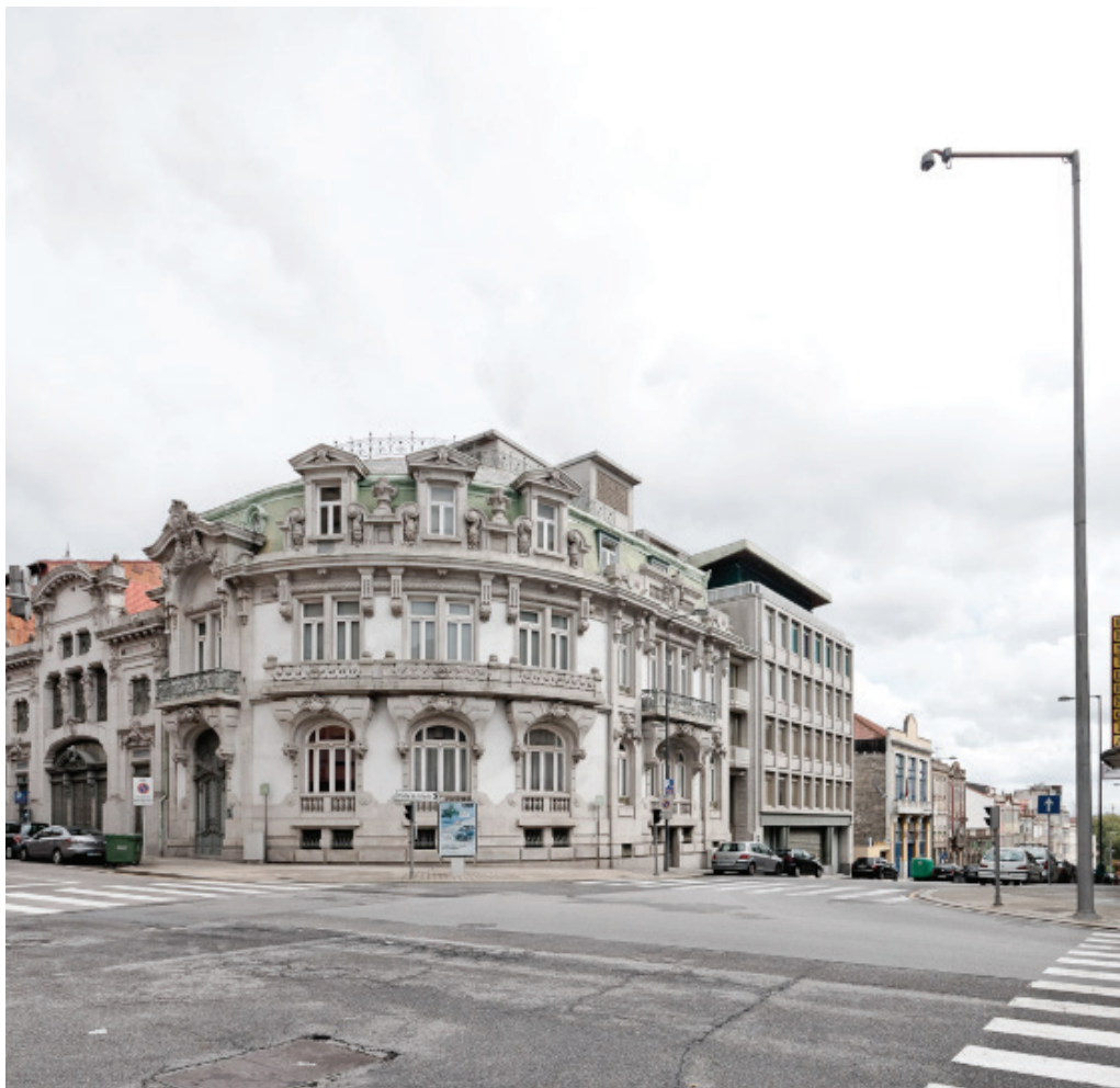
104 | O edifício preexistente e a ampliação. Fotografia de Carlos A. Castro
