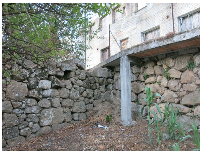
129 | Alçado sul. A ruína e o terreno. Agosto 2016
