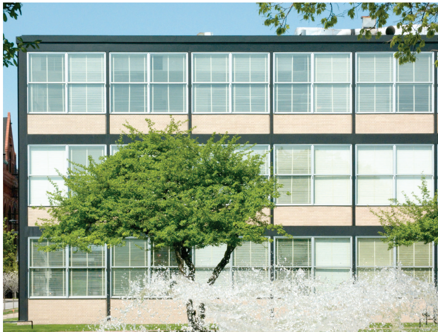
039 | Bauakademie, Karl Friedrich Schinkel, 1836, Berlim. Detalhe da fachada. 040 | Wishnick Hall, Chicago, 1946, Mies Van der Rohe. Detalhe e composição da fachada.
