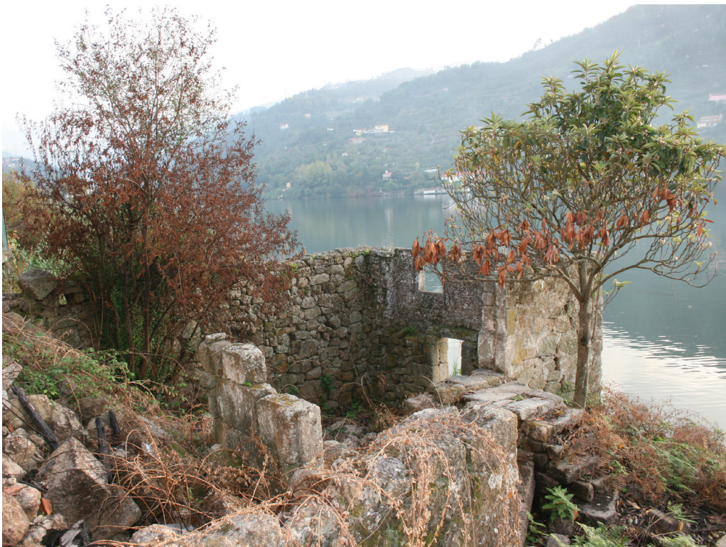
149 | A ruína invadida pela Natureza. Março 2016 150 | Ruína vista desde poente. Outubro 2009
