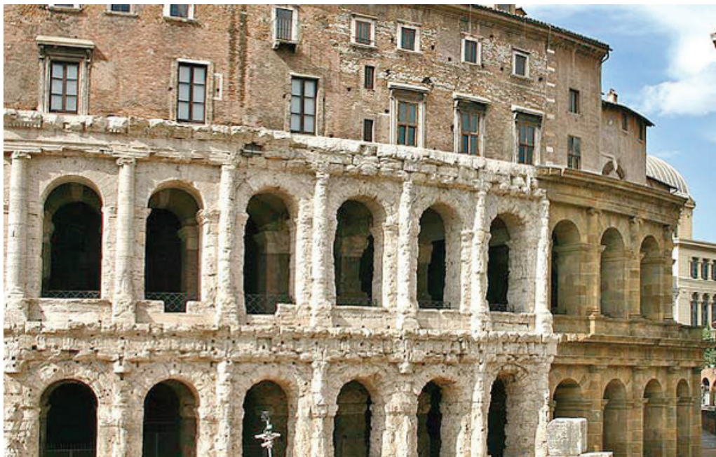
029 | A construção do novo sobre o antigo. Secção realizada por P. Fidenzoni, relação da recente ampliação do Palácio Savelli com as ruínas do teatro de Marcello, Roma, Itália.
