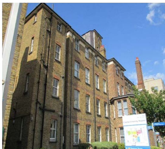
写真 5 : Croydon University Hospital 創立時代の建物
