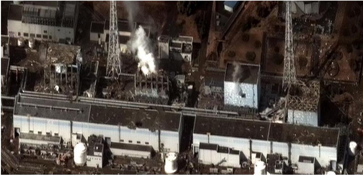
Slika 3.1: Poškodovani reaktor 4 [10]
