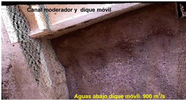
Fig. 7: Foso de erosión aguas abajo del dique móvil. Imagen RGB.
