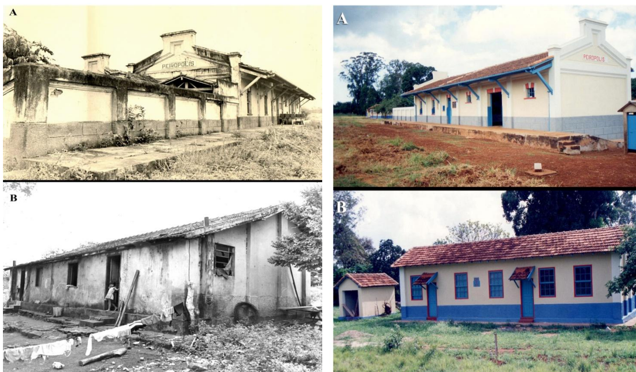
Figura 02. Estado de conservación de las estructuras. A-Estación de tren. B- Casa del jefe de la estación. Fotos de la colección fotográfica CCCP tomadas en la década de 1980. Fuente: autor desconocido.
