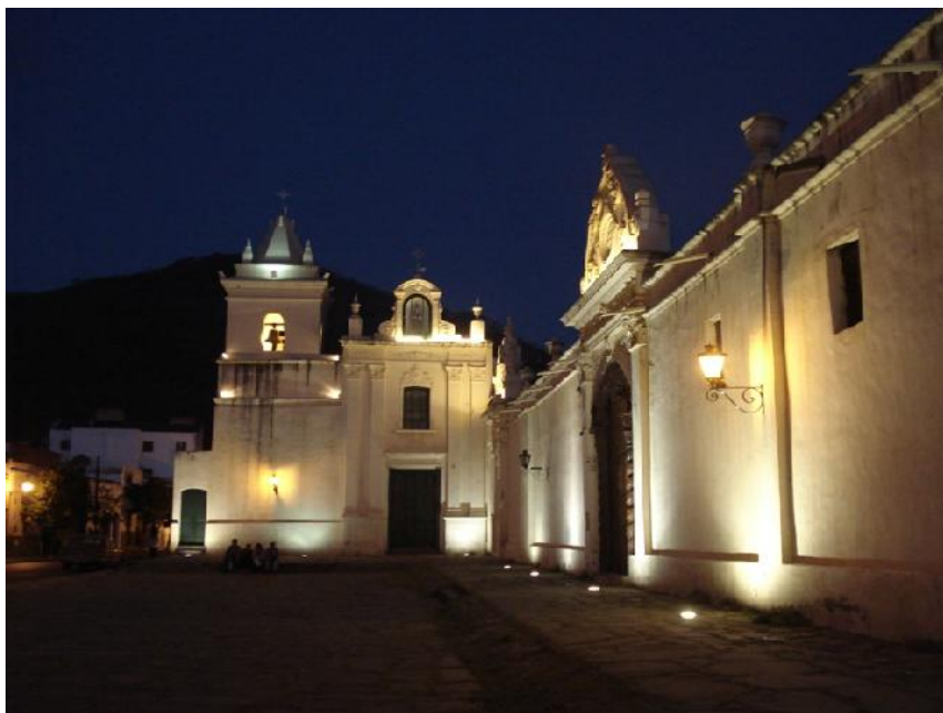
Figura 2: Convento de San Bernardo. Obras de pintura e iluminación
