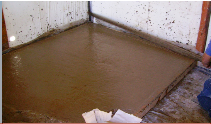
Figure 4- Floor in the Nuevo Golf borough made with rubble and stabilized soil with cement and lime on a construction-grade polyethylene sheet placed over a packed-earth floor (design Rotondaro-Cacopardo, PIP CONICET 112-1635) 2013. / Piso en barrio Nuevo Golf con cascotes y suelos estabilizados con cemento y cal sobre polietileno de obra, sobre piso de tierra apisonado (diseño Rotondaro-Cacopardo, PIP CONICET 112-1635) 2013.
