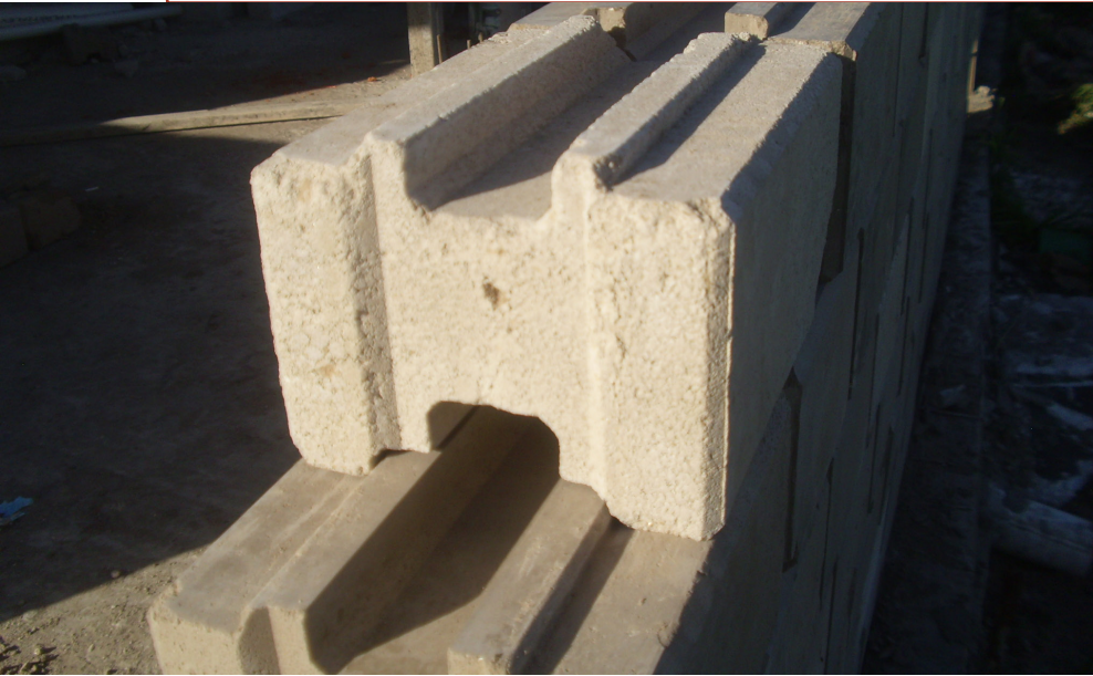
FIGURE 2. A wall made of compound soil-cement blocks with inner bonding in Monte Terrabusi, Mardel Plata. The sanitary sector of a new living module. 2013. (Credit: Fernando Cacopardo). / Muro de bloques intertrabados de suelo-cemento en Monte Terrabusi, Mar del Plata. Sector sanitario de módulo habitacional nuevo. 2013. (crédito: Fernando Cacopardo).
