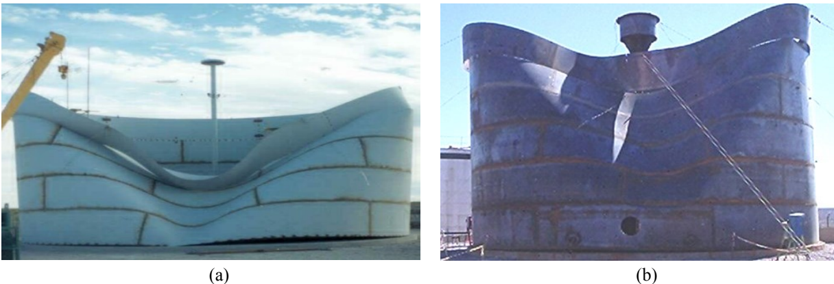
Figura 1: Estructuras colapsadas: (a) tanque A; (b) tanque B.
